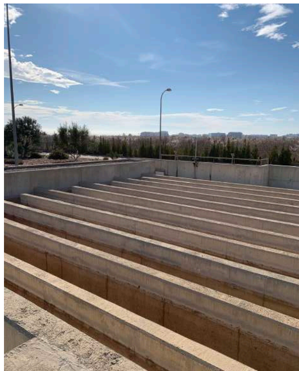
Figura M.14. Circuito de cloración. Fuente: Foto sacada en la EDAR de Oropesa.
