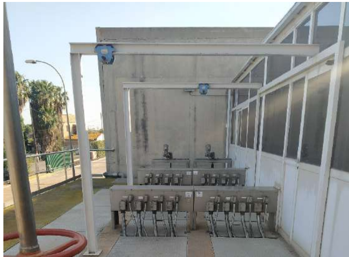
Figura M.13. Lámparas UV montadas en canal. Imagen sacada en la EDAR de Castellón.
