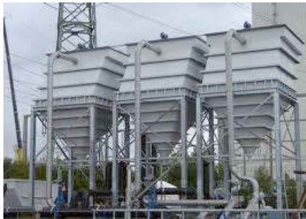
Figura M.6. Decantador lamelar. Fuente: AEMA ( http://aguasindustriales.es )
