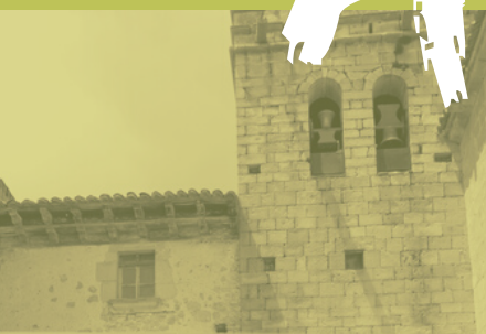
Rehabilitació del Santuari de Sant Joan de Penyagolosa
