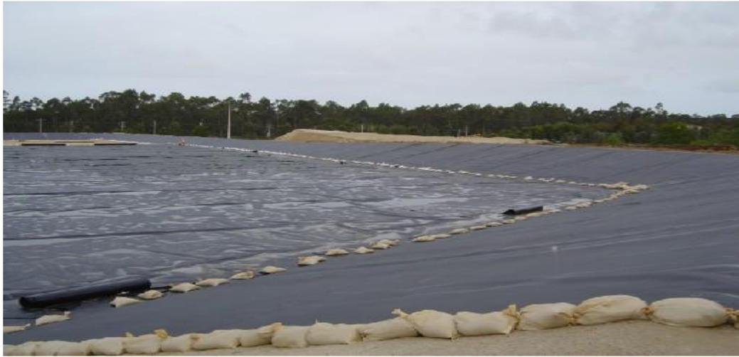
Fig.2.6. Capas de aislamiento de base de polietileno
