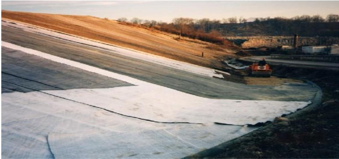
Fig.2.7. Asentamiento del área del proyecto e implementación del sistema de aislamiento del suelo
