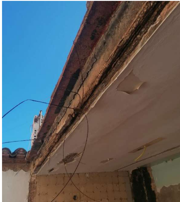
Imagen 101: Elemento estructural en mal estado en proceso de demolición (elaboración propia)
