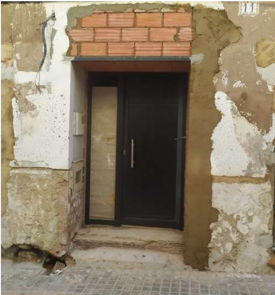
Imagen 139: Detalle instalación puerta de entrada a vivienda (elaboración propia)
