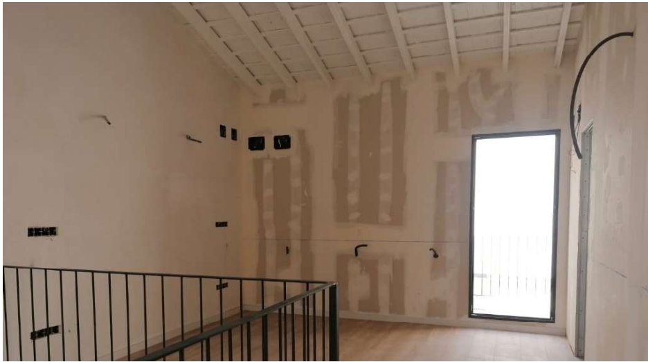
Imagen 124: Tabiquería y trasdosado autoportante una vez aplacado y encintado (elaboración propia)
