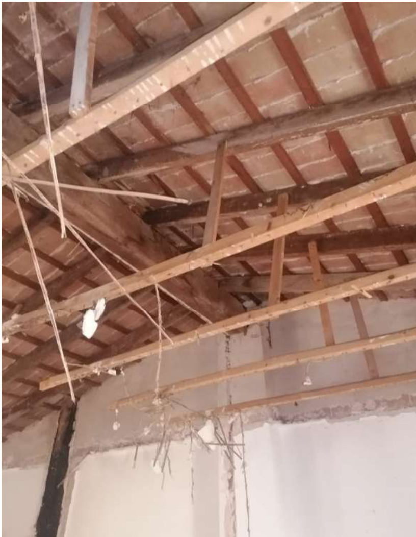
Imágenes 112 y 113: Demolición del falso techo de cañizo (elaboración propia)
