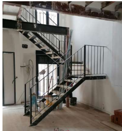
Imágenes 37 y 38: Instalación de barandilla de hierro en escalera que sube a primera planta (elaboración propia)
