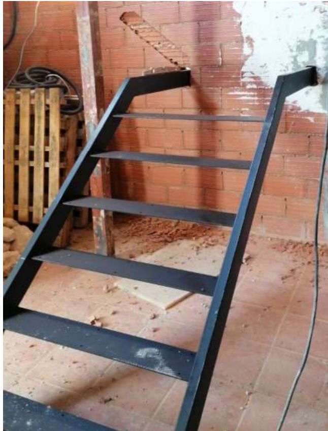
Imagen118: Montaje de estructura metálica de escalera (elaboración propia)
