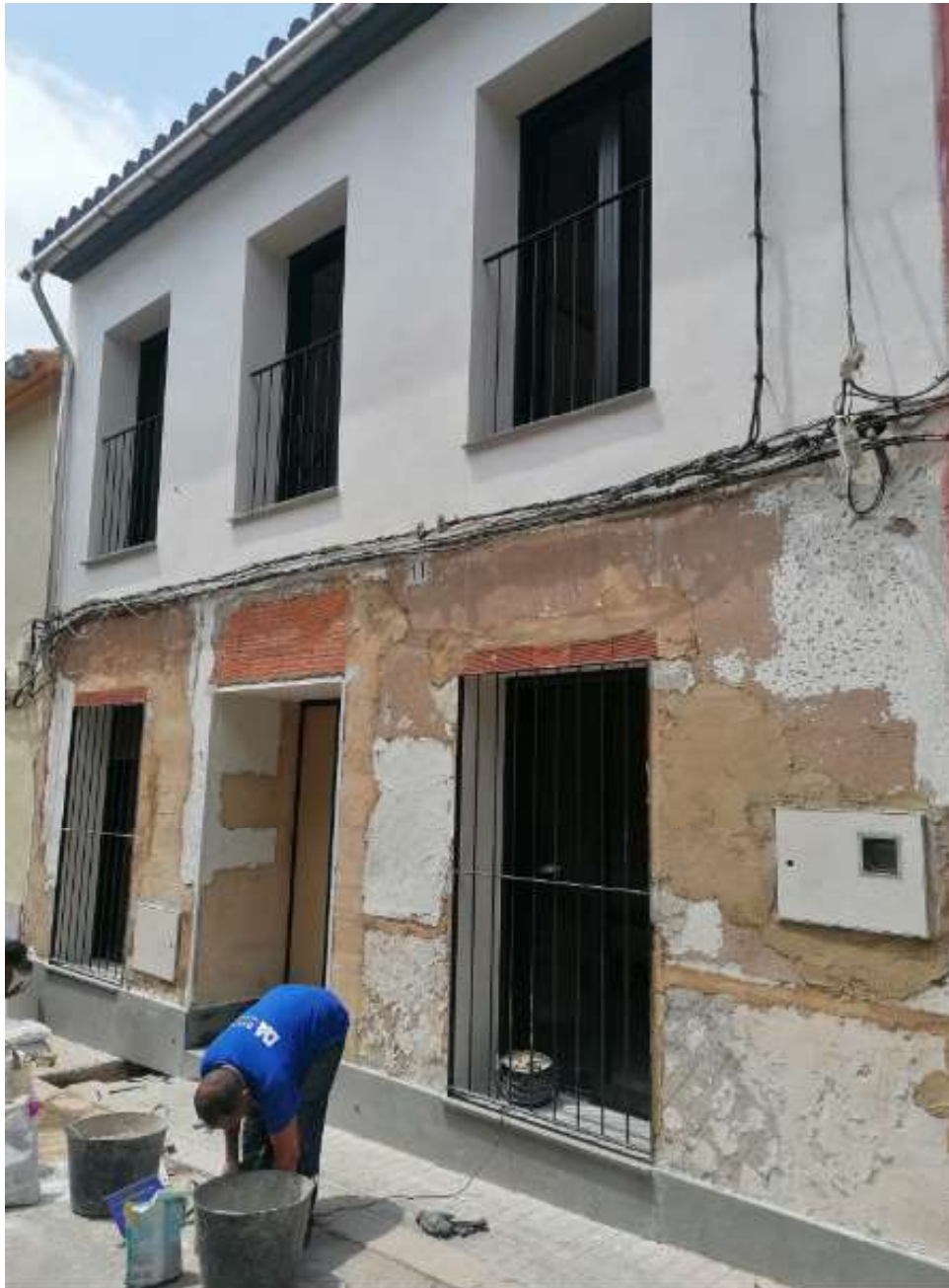
Imagen 140: Trabajos en fachada, colocación del zócalo de piedra natural (elaboración propia)
