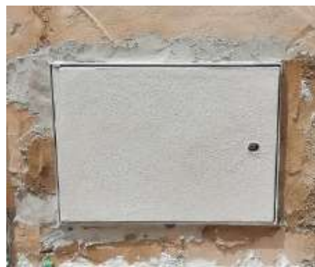
Imágenes 141 y 142: Trabajos en fachada, detalle hornacinas para contadores de agua y electricidad (elaboración propia)
