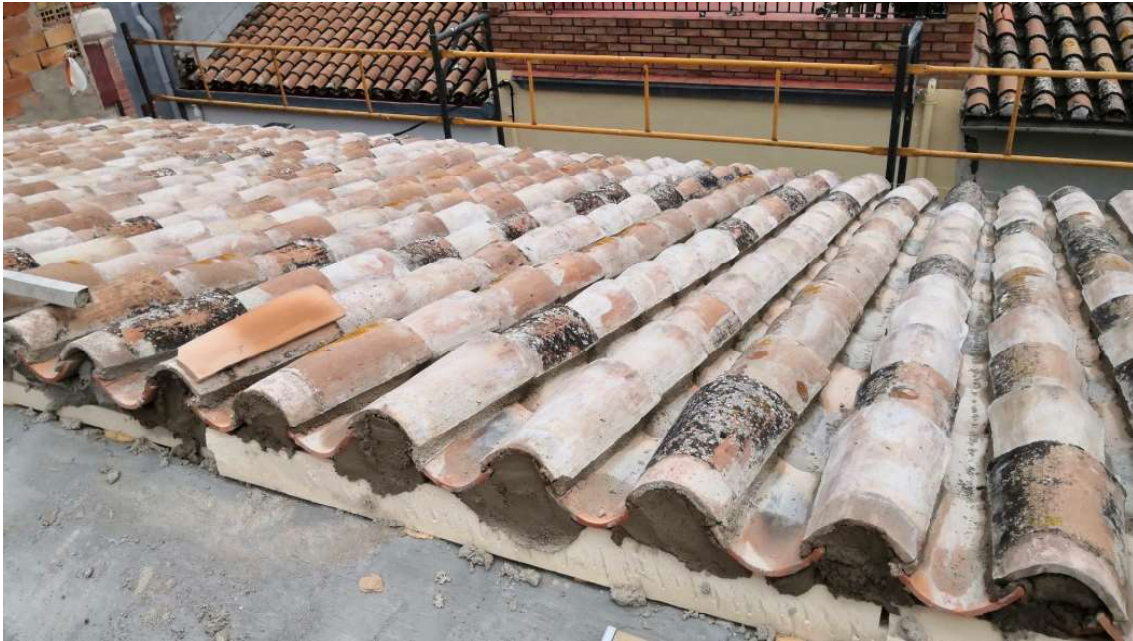
Imagen 134: Detalle de la elaboración de la cubierta de teja árabe (elaboración propia)
