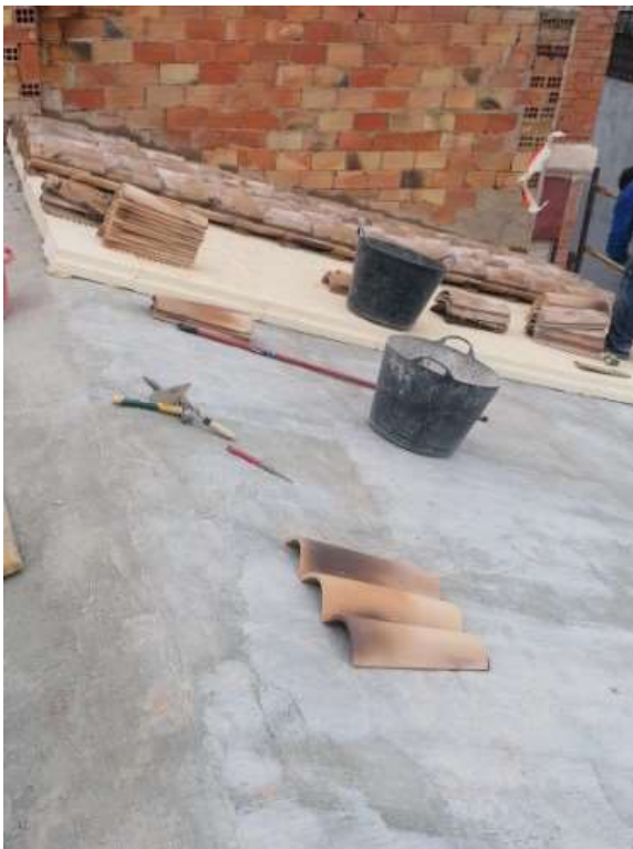
Imágenes 130, 131, 132 y 133: Secuencia de levantado, regularización y montaje de XPS y teja árabe (elaboración propia)
