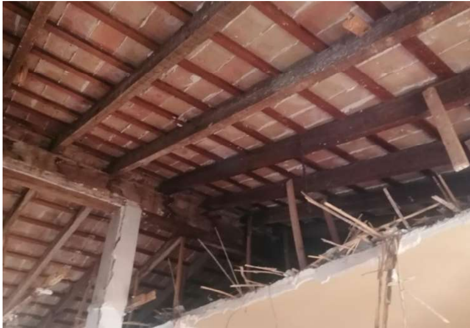
Imagen 24: Demolición del falso techo de cañizo (elaboración propia)
