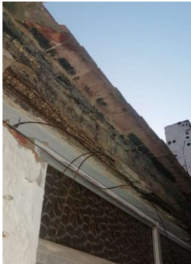
Imagen 102: Elemento estructural en mal estado en proceso de demolición (elaboración propia)
