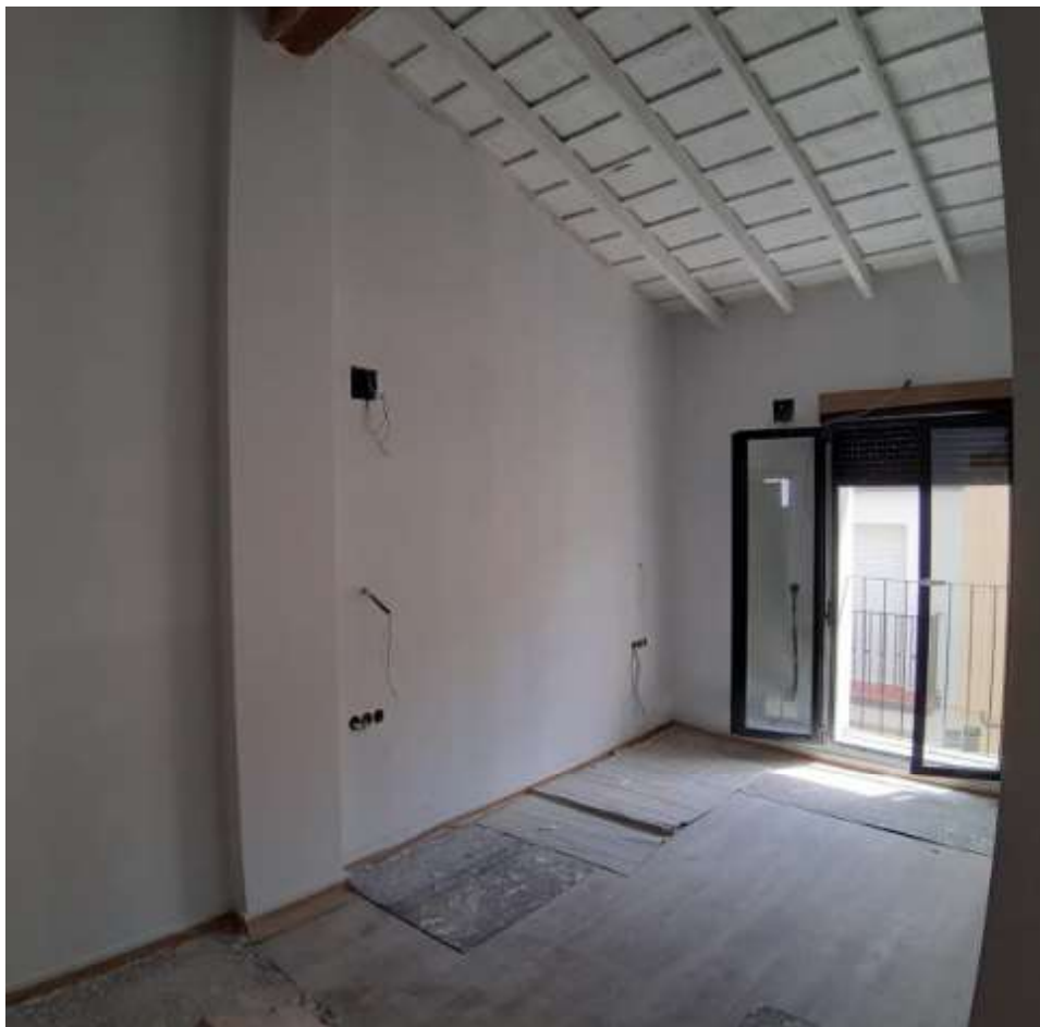
Imágenes 156,157 y 158: Estado de la habitación al momento de la entrega del trabajo final de grado (elaboración propia)
