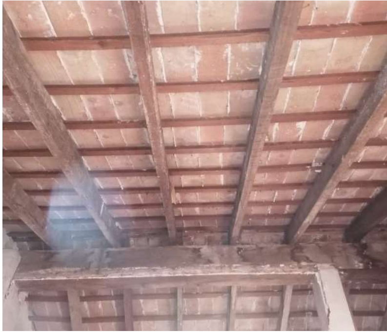
Imagen 114: Estructura portante de la cubierta inclinada (elaboración propia)
