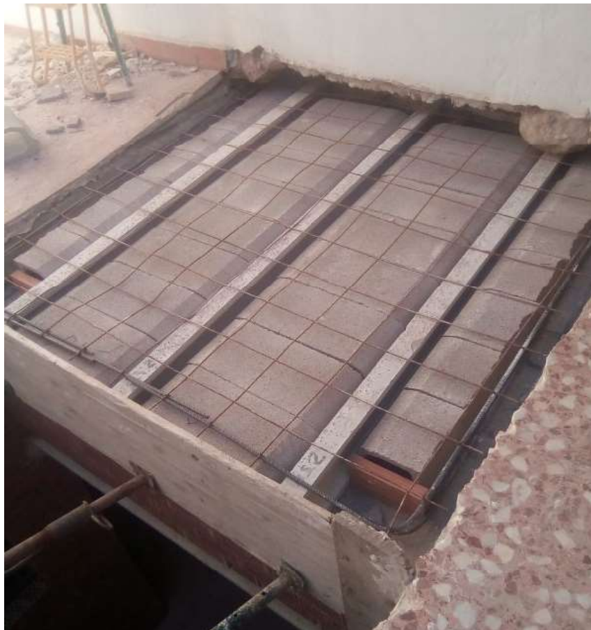
Imágenes 110 y 111: Montaje de forjado unidireccional en patio (elaboración propia)
