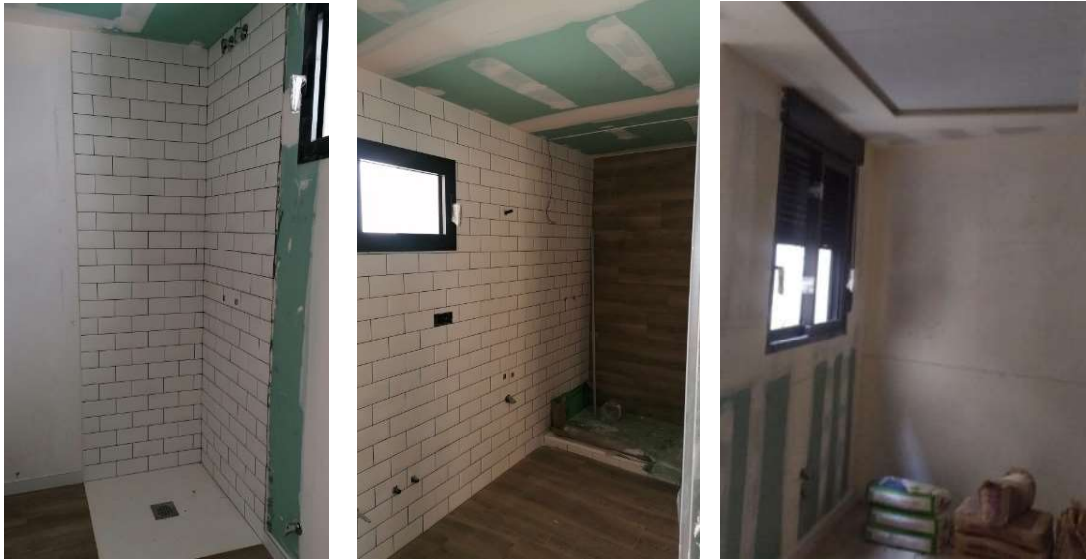
Imágenes 32, 33 y 34: Instalación de placas hidrófugas de yeso laminado en cuartos húmedos (elaboración propia)
