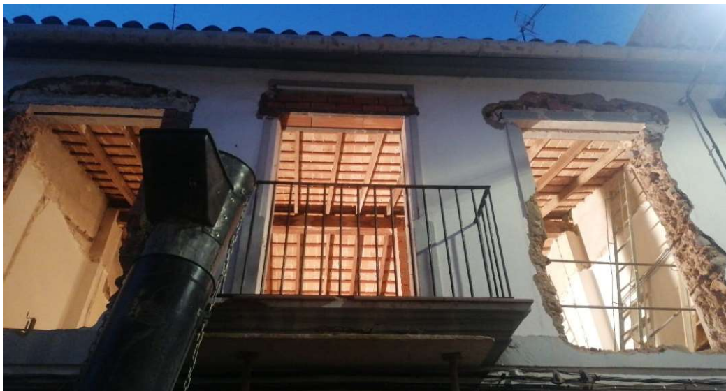
Imágenes 29,30 y 31: Apertura de huecos para carpintería metálica en fachada (elaboración propia)
