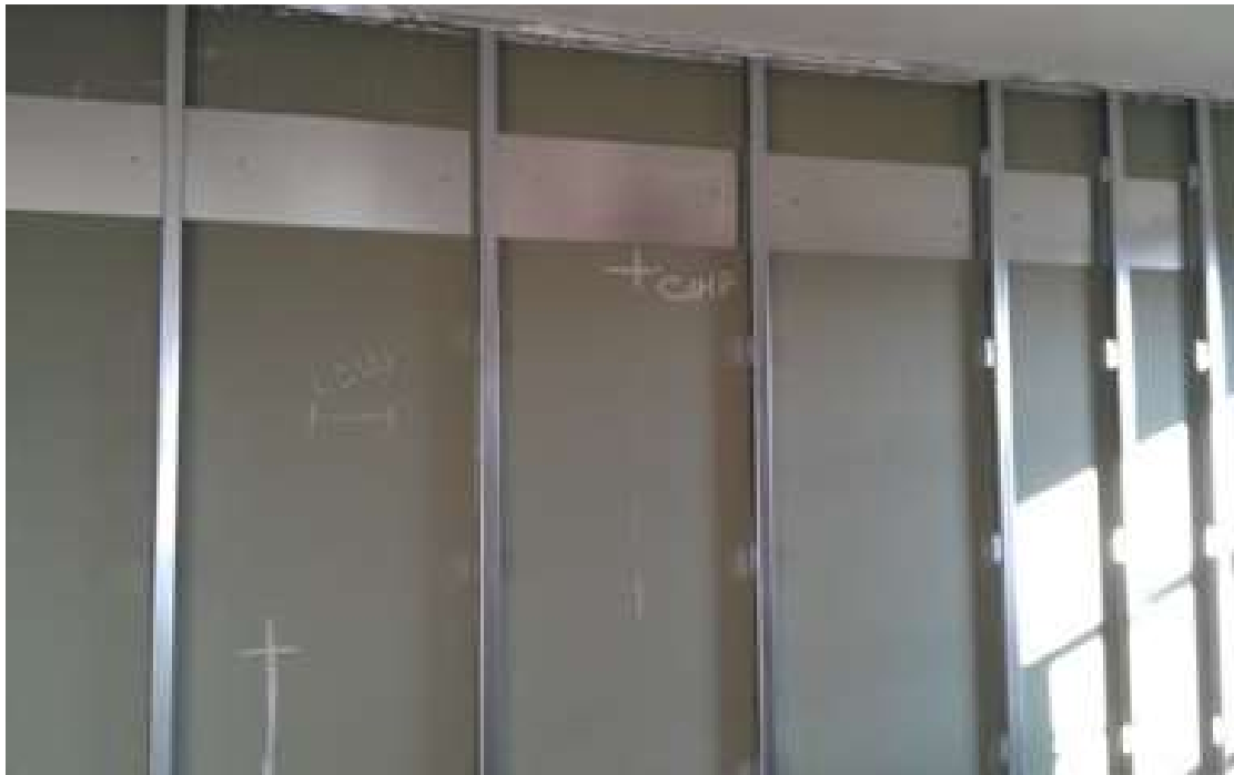
Imagen 36: Instalación de chapas de refuerzo para sustentar elementos colgados de la tabiquería de escayola (elaboración propia)
