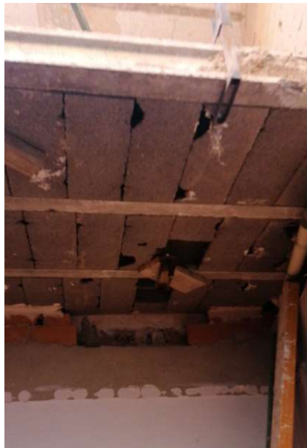
Imágenes 107, 108 y 109: Montaje de maquinillo, detalles de arriostramiento y apuntalamiento (elaboración propia)
