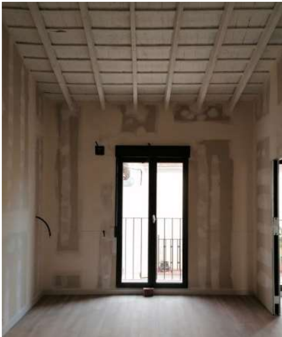
Imagen 125: Tabiquería y trasdosado autoportante una vez aplacado y encintado (elaboración propia)
