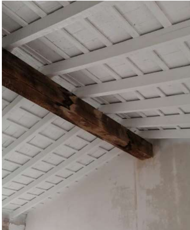
Imagen 116: Detalle de viga de cumbra en estado original, previo al tratado (elaboración propia)
