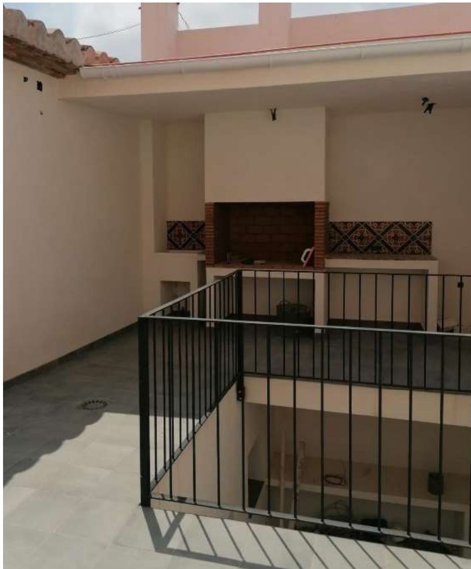
Imágenes 126, 127, 128 y 129: Secuencia de la construcción del banco exterior con barbacoa (elaboración propia)
