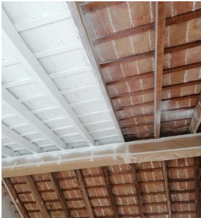
Imagen 115: Estructura portante de la cubierta inclinada, limpia, tratada y pintada (elaboración propia)
