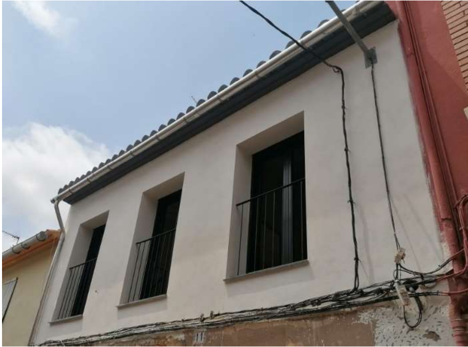
Imagen 138: Fachada una vez revocada la parte superior y pintado el alero de la cubierta (elaboración propia)
