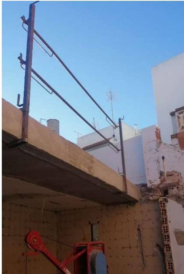
Imagen 105: Elemento estructural reconstruido y debidamente protegido (elaboración propia)
