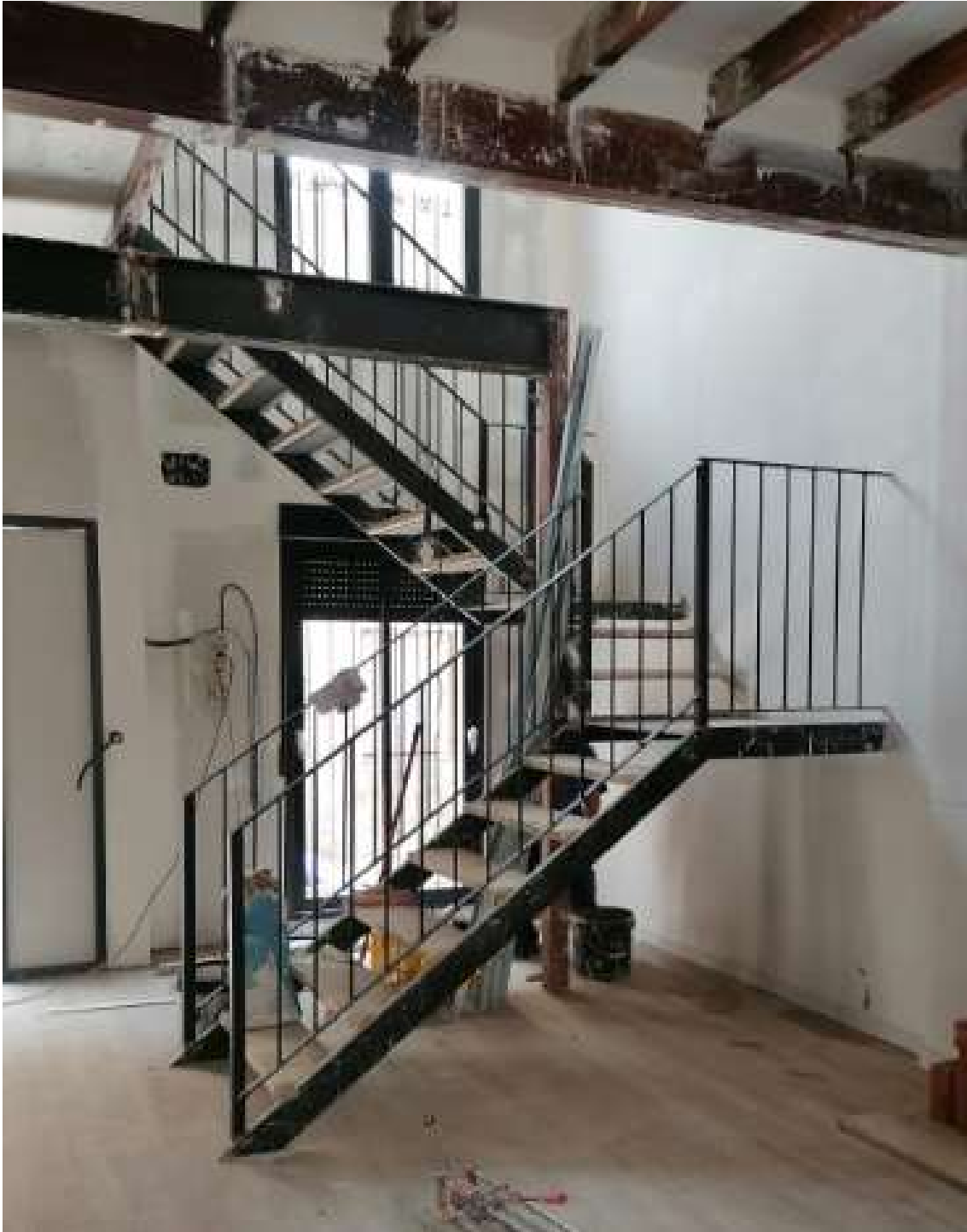
Imagen 121: Montaje de barandilla de hierro con pletina plana y barrotillo circular macizo (elaboración propia)
