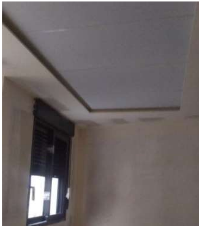
Imagen 35: Construcción de tabica de cambio de nivel en techo registrable de escayola (elaboración propia)
