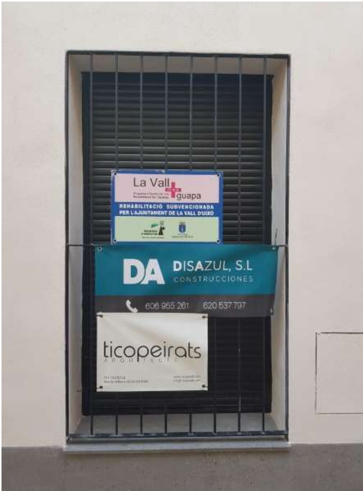
Imagen 144: Imagen para la justificación de los trabajos en fachada, para recibir ayuda municipal (dirección facultativa)
