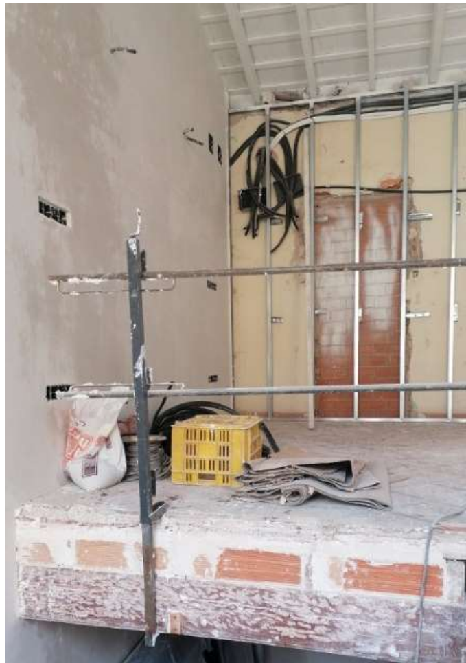
Imágenes 122 y 123: Montaje de estructura autoportante para tabiquería interior y trasdosados (elaboración propia)
