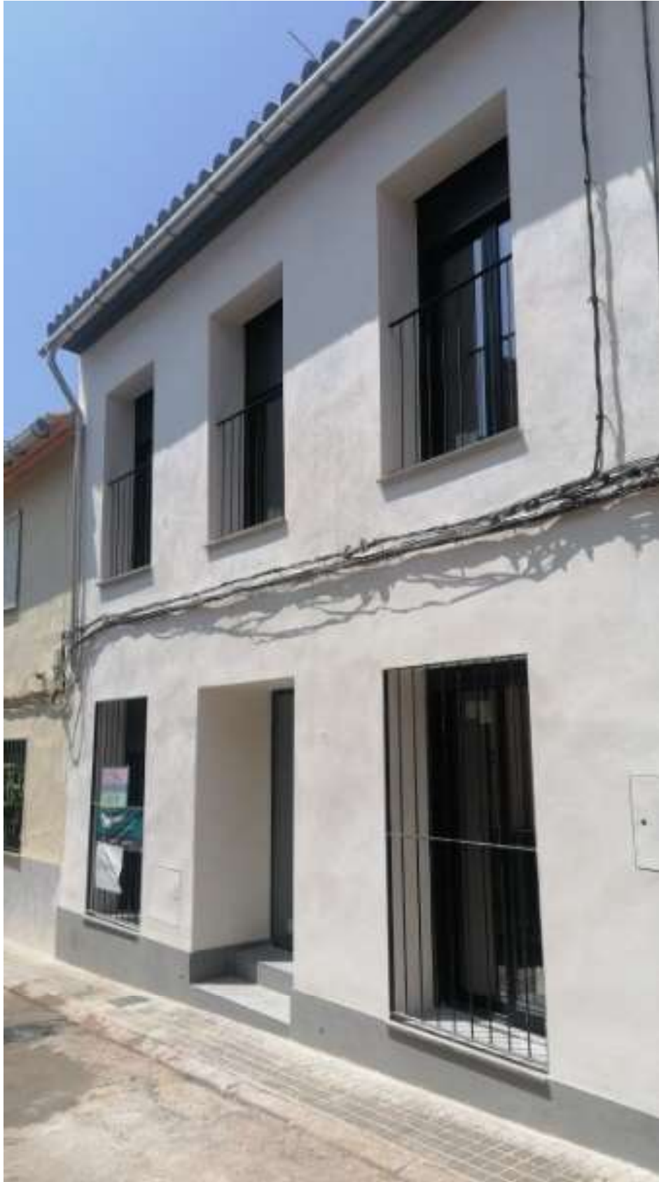
Imagen 143: Finalización de los trabajos en fachada (elaboración propia)
