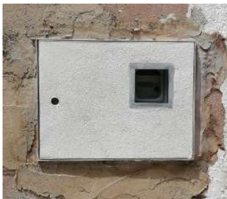
Imágenes 141 y 142: Trabajos en fachada, detalle hornacinas para contadores de agua y electricidad (elaboración propia)
