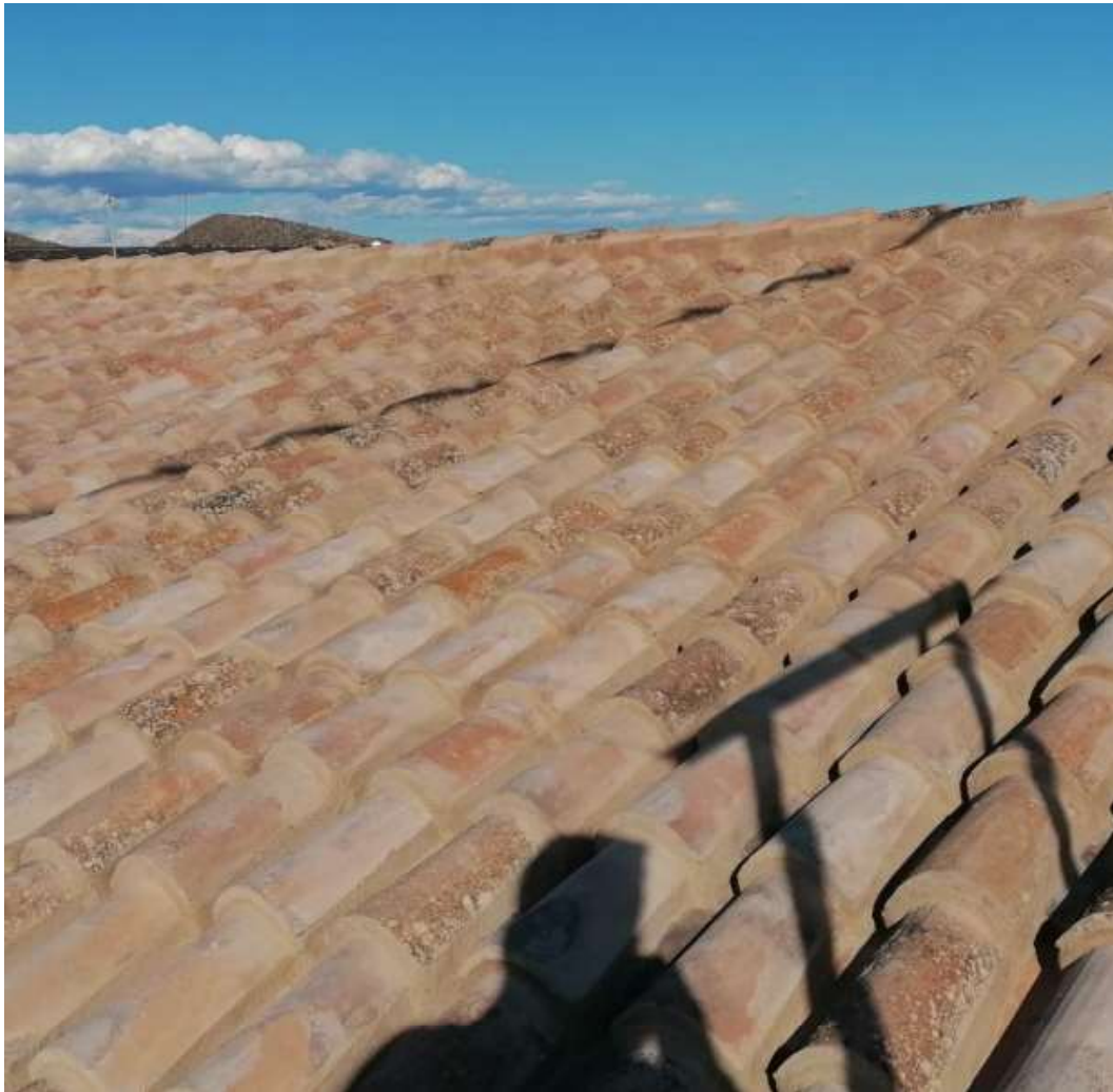
Imágenes 135, 136 y 137: Cubierta de teja árabe terminada (elaboración propia)
