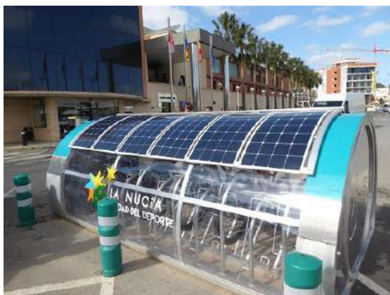
Ilustración 25. Paneles solares en aparcabicis
