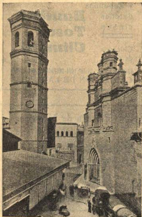
CASTELLON.—La torre campanario
