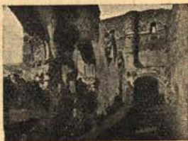
Claustro del ruinoso monasterio de Benifassá.
