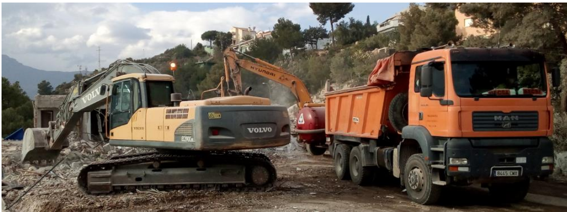
Figura 29: Ciclo de carga de escombros a camión. (Fuente propia)
