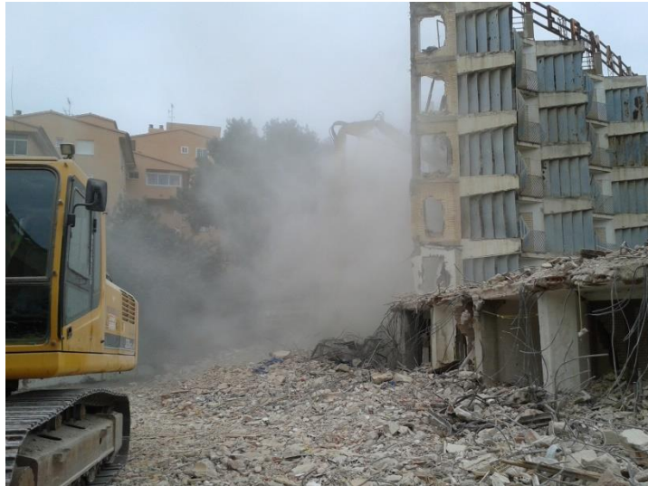
Figura 16: Columna de polvo en fase de derribo sobre rasante. (Fuente propia)
