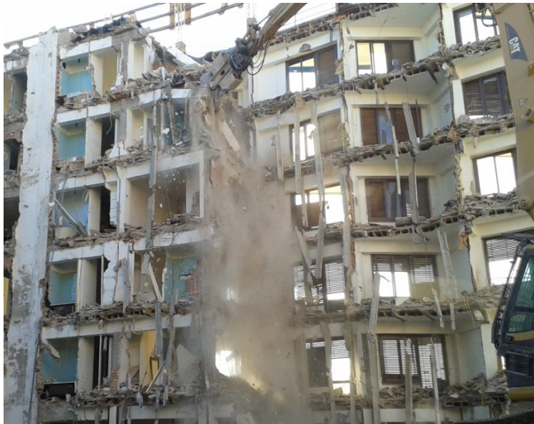
Figura 25: Proceso de derribo de crujía. (Fuente propia)
