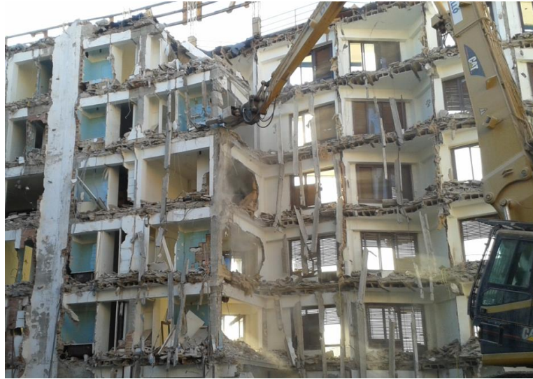
Figura 24: Proceso de derribo de crujía. (Fuente propia)
