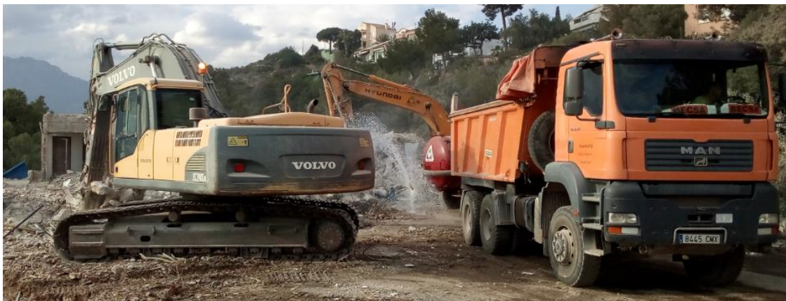
Figura 30: Ciclo de carga de escombros a camión. (Fuente propia)
