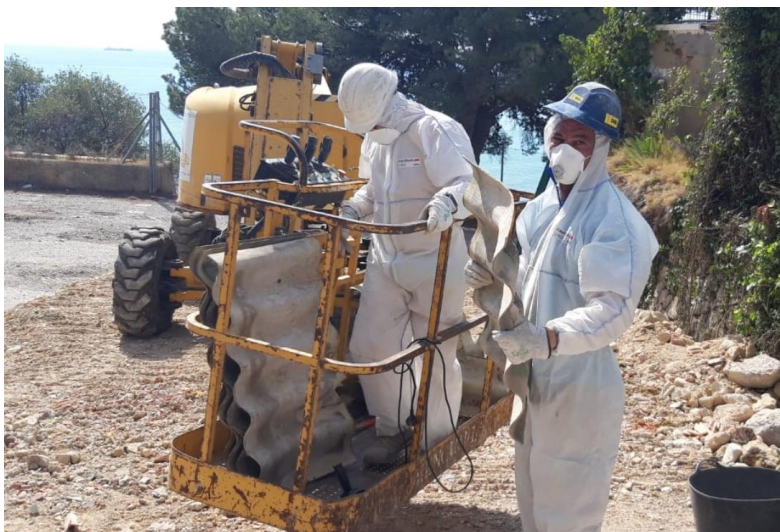
Figura 13: Desmontado de placas de fibrocemento. (Fuente propia)
