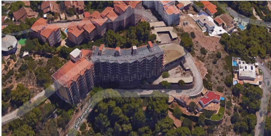
Figura 22: Vista aérea del Complejo Termalismo. (Fuente Google maps)
