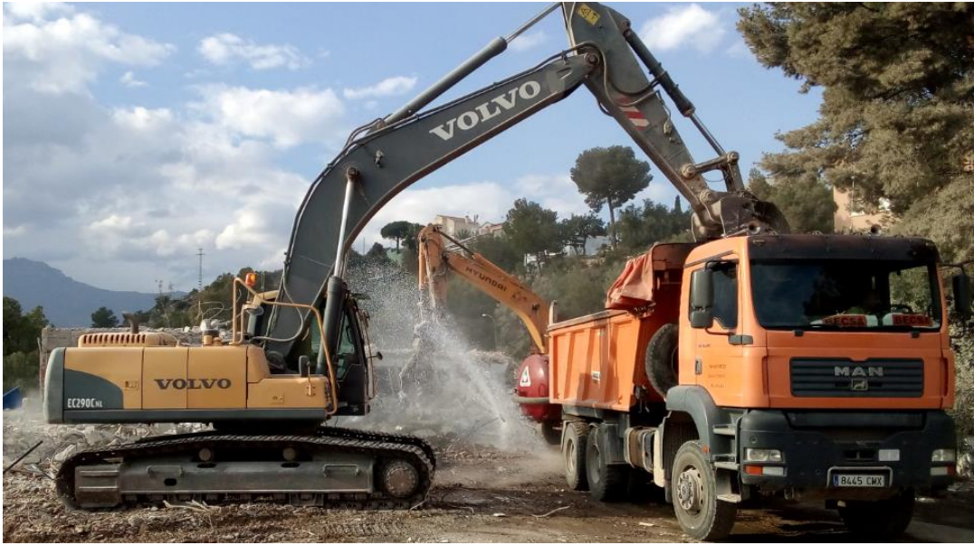
Figura 31: Ciclo de carga de escombros a camión. (Fuente propia)
