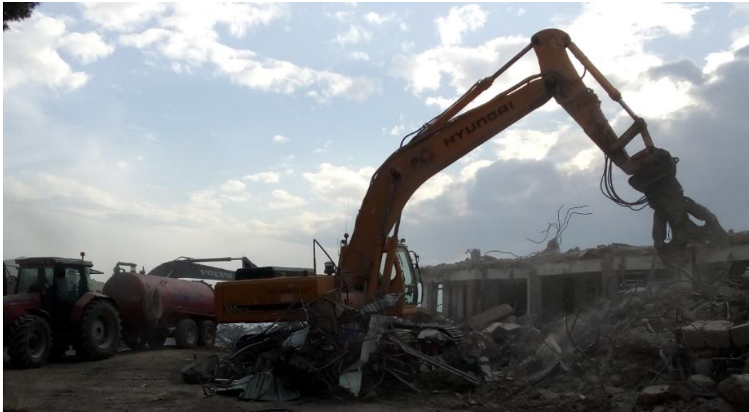
Figura 32: Separación de materiales y escombros a pie de obra. (Fuente propia)
