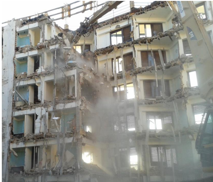
Figura 27: Proceso de derribo de crujía. (Fuente propia)
