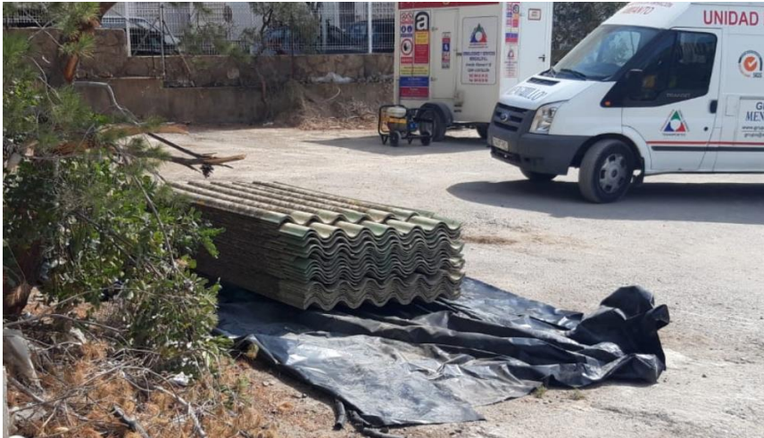
Figura 12: Apilado y encapsulado de placas de fibrocemento. (Fuente propia)
