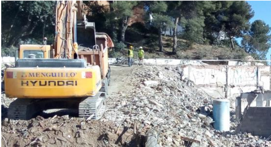
Figura 10: Finalización del derribo de sótanos. (Fuente propia)
