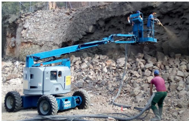
Figura 15: Gunitado de taludes. (Fuente propia)
