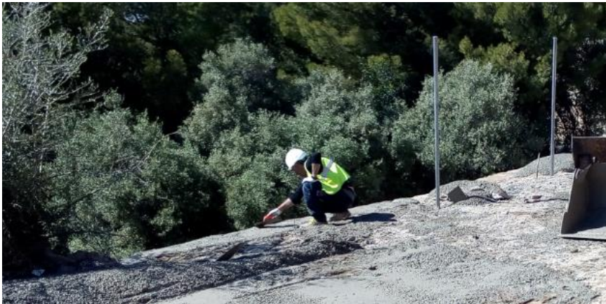
Figura 14: Hormigonado de cabeza de muro. (Fuente propia)
