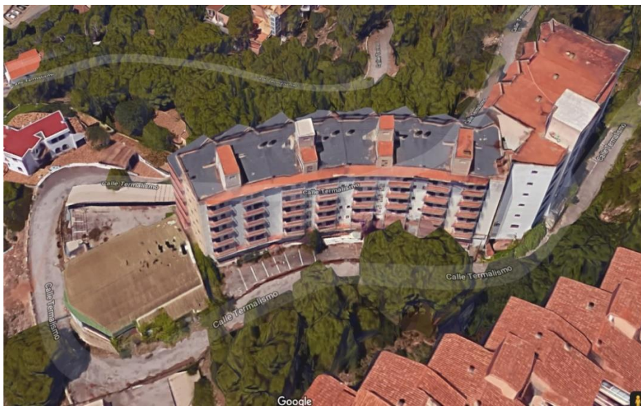
Figura 23: Vista aérea del Complejo Termalismo. (Fuente Google maps)
