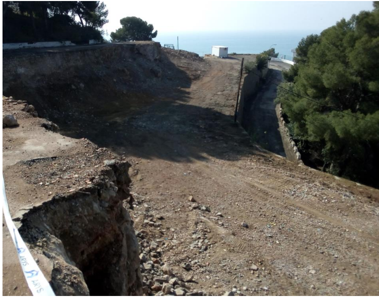
Figura 33: Aspecto finca en final de obra. (Fuente propia)
