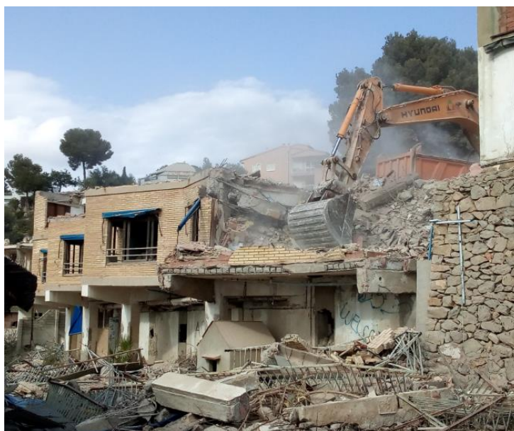
Figura 9: Derribo de sótanos y carga de material (Fuente propia)
