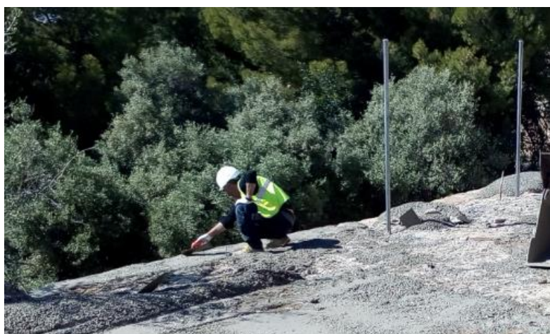
Figura 21: Operario hormigonando la cabeza de muro. (Fuente propia)
