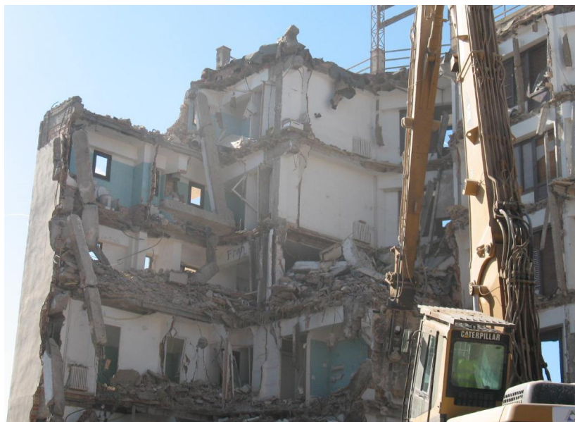
Figura 8: Derribo últimas crujeas edificio principal, final derribo sobre rasante (Fuente propia)
