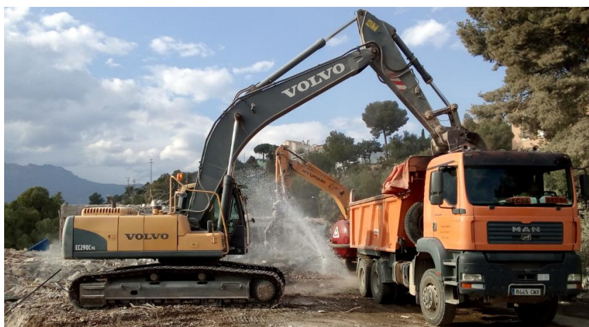
Figura 10: Derribo de sótanos y carga de escombros (Fuente propia)
