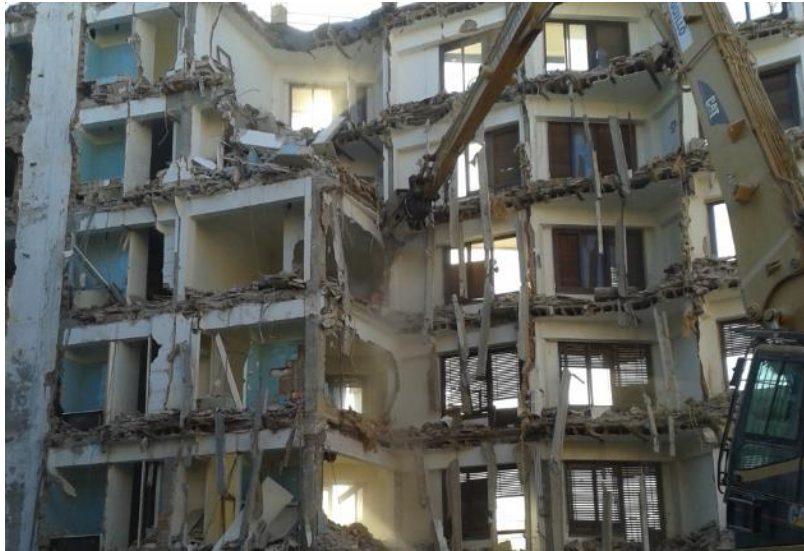
Figura 28: Proceso de derribo de siguiente crujía. (Fuente propia)
