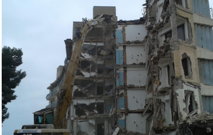
Figura 7: Derribo de cubierta, avance en la ejecución (Fuente propia)
