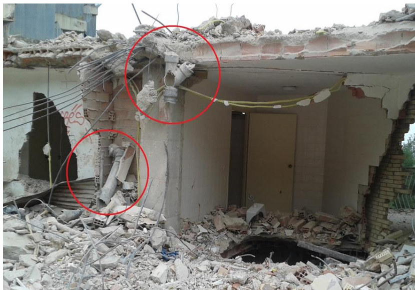
Figura 17: Aparición de bajantes de fibrocemento en fase de derribo sobre rasante. (Fuente propia)
