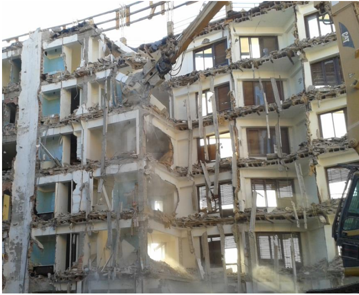
Figura 26: Proceso de derribo de crujía. (Fuente propia)
