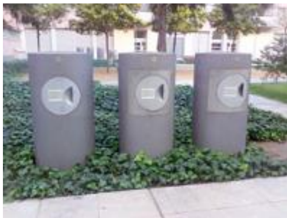
Figura 9. Recogida Neumática (MITECO, 2020).
