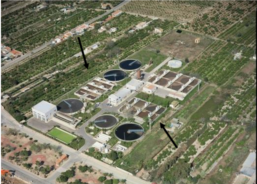
Ilustración 2: Vista aérea de la EDAR
