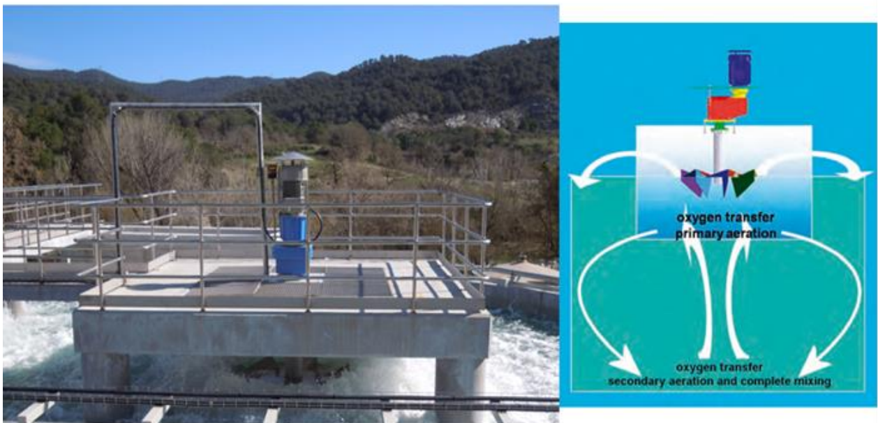
Ilustración 1: Esquema aeración superficial
