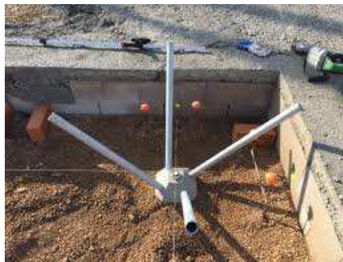
Fig. 16. Sistema PILOEDRE preparado para ser enterrado en el piso para acoplar una estructura modular.
