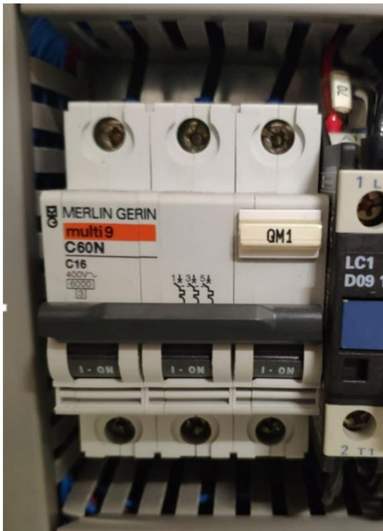
Ilustración 25: Disyuntor magnetotérmico C60N (QM1)
