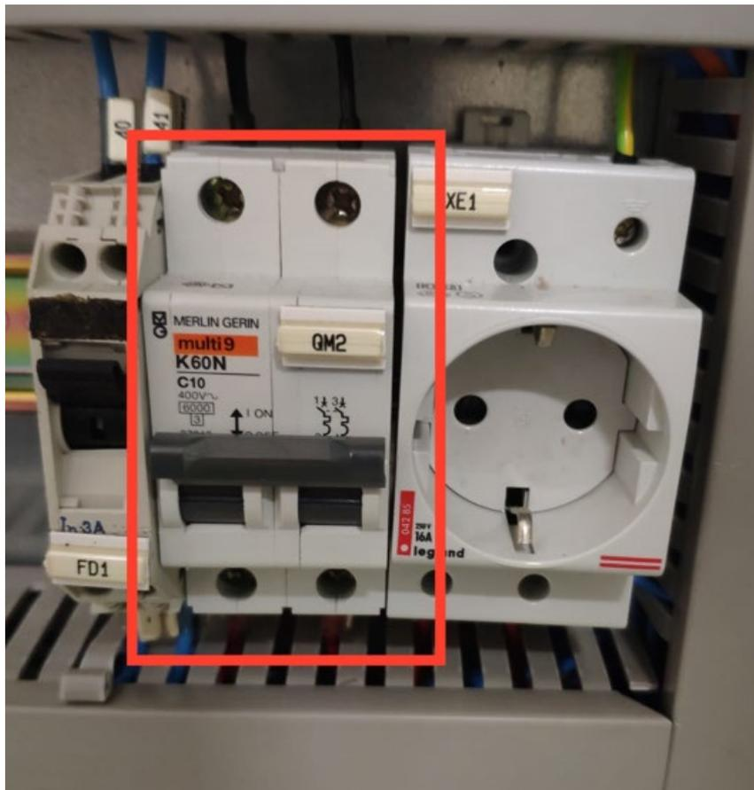
Ilustración 28: Disyuntor magnetotérmico K60N (QM2)
