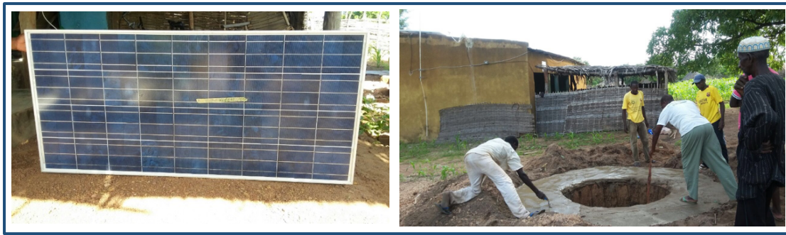
Figura 4: Maternidad de Afía. Placas solares (panel izquierdo). Construcción de pozo de la maternidad de Afía (panel derecho). Fuente: Alpha Diallo.
