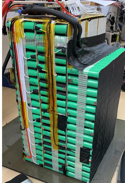
Figura 8: Montaje baterías Fuente: Elaboración Propia
