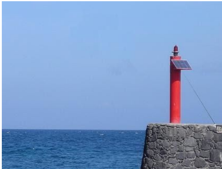
Ilustración 1. Señal de entrada a puerto alimentada por panel fotovoltaico
