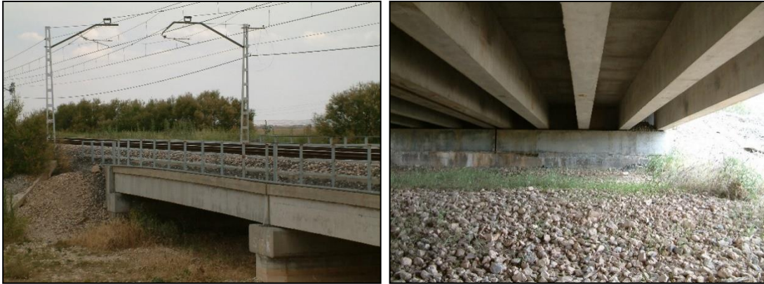
Fig. 13: Imágenes del puente sobre el río Guadiana Viejo (15) .
