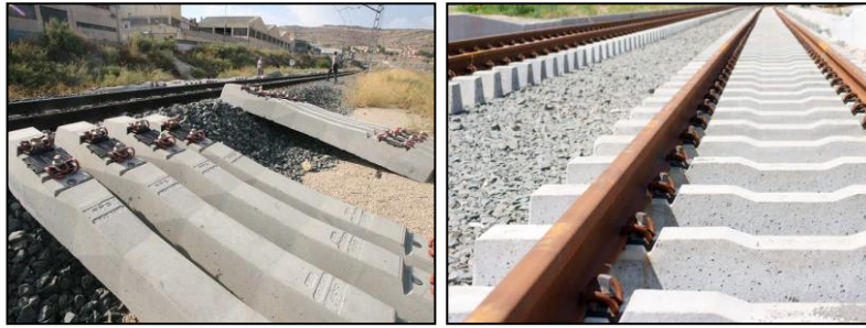
Fig. 3: Traviesas de hormigón (1,2).
