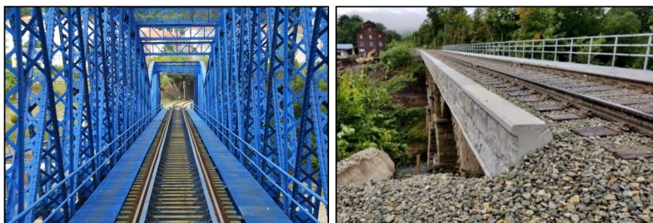
Figura 8: Pont metàl·lic sense balast (esquerra) i pont de formigó amb balast (dreta) (12,13).
