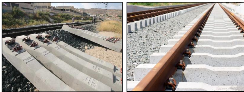
Figura 3: Travesses de formigó (1,2).
