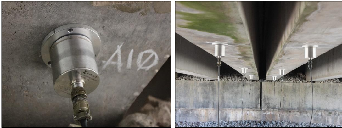
Figura 46: Instal·lació dels acceleròmetres (15).
