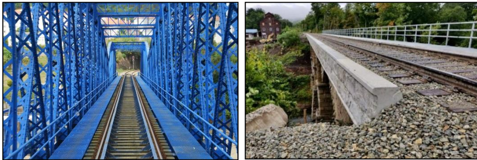
Fig. 8: Puente metálico sin balasto (izquierda) y puente de hormigón con balasto (derecha) (12, 13).
