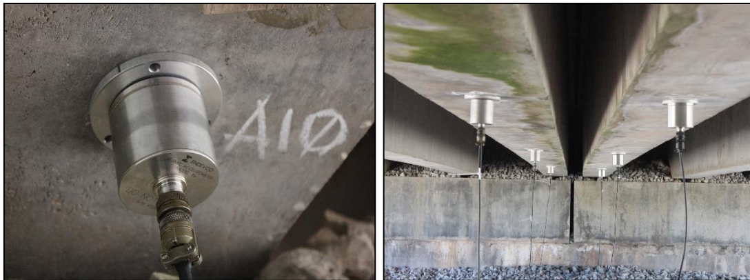
Fig. 46: Instalación de los acelerómetros (15).
