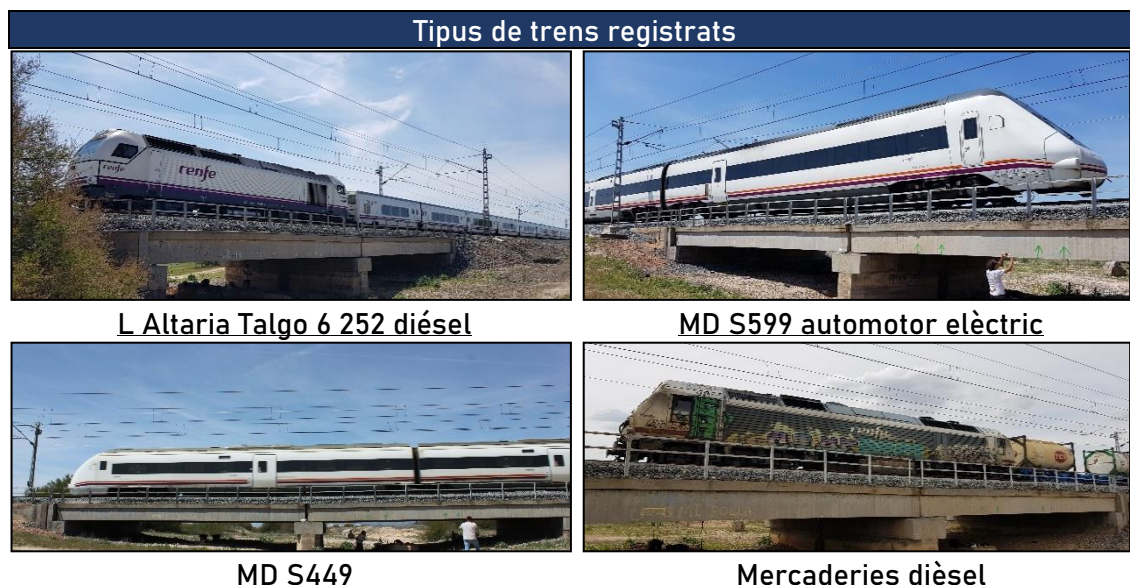
Figura 48: Els quatre tipus de trens que passaren per pel pont durant la campanya experimental (15).
