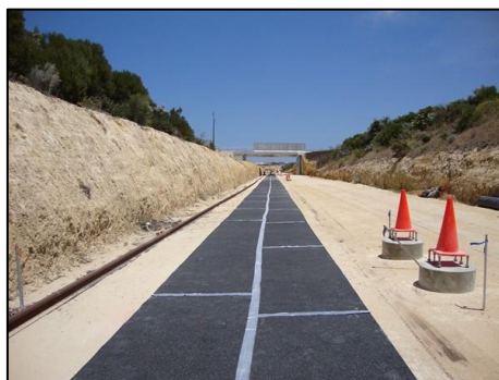
Figura 7: Capa de sotabalast (11).
