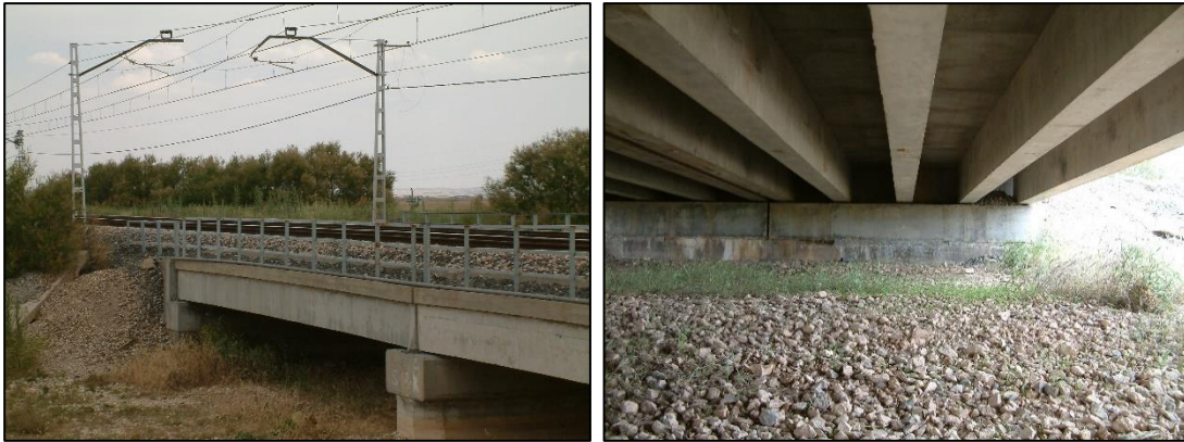
Figura 13: Imatges del pont sobre el riu Guadiana Viejo (15).
