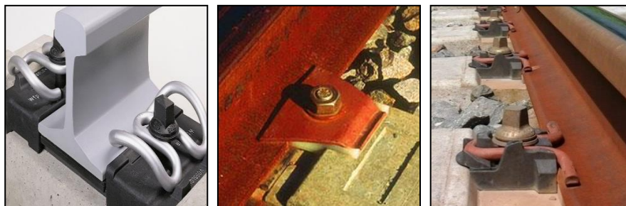
Fig. 4: Sistemas de sujeción Vossloh (izquierda), Nabla (centro) y Pandrol (derecha) (3,4,5).
