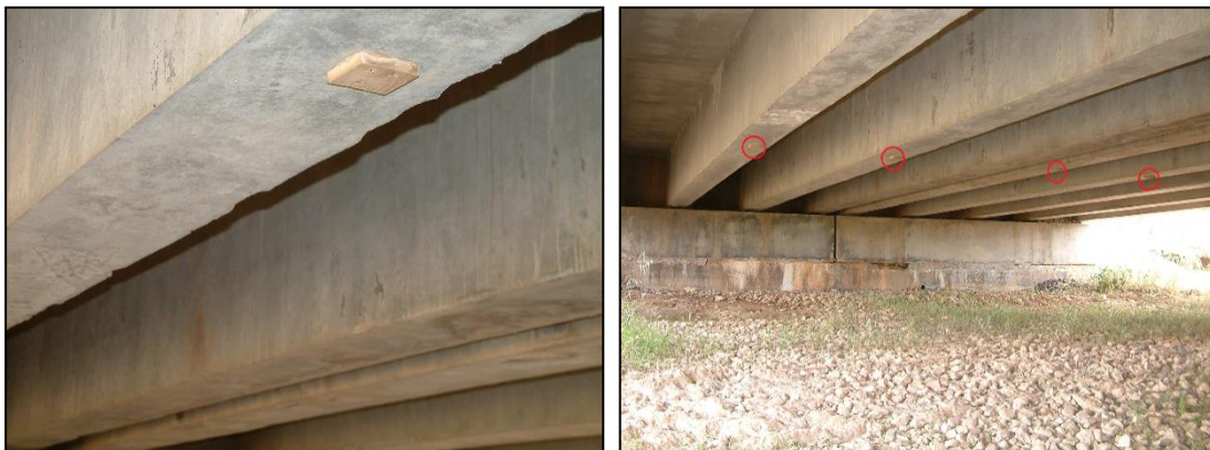
Fig. 44: Localización de los dispositivos de medida (15).
