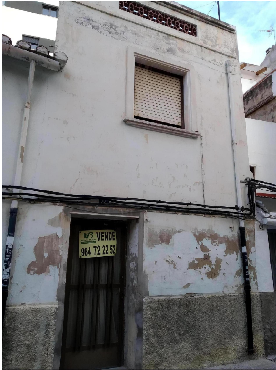
Fotografía de la fachada principal
