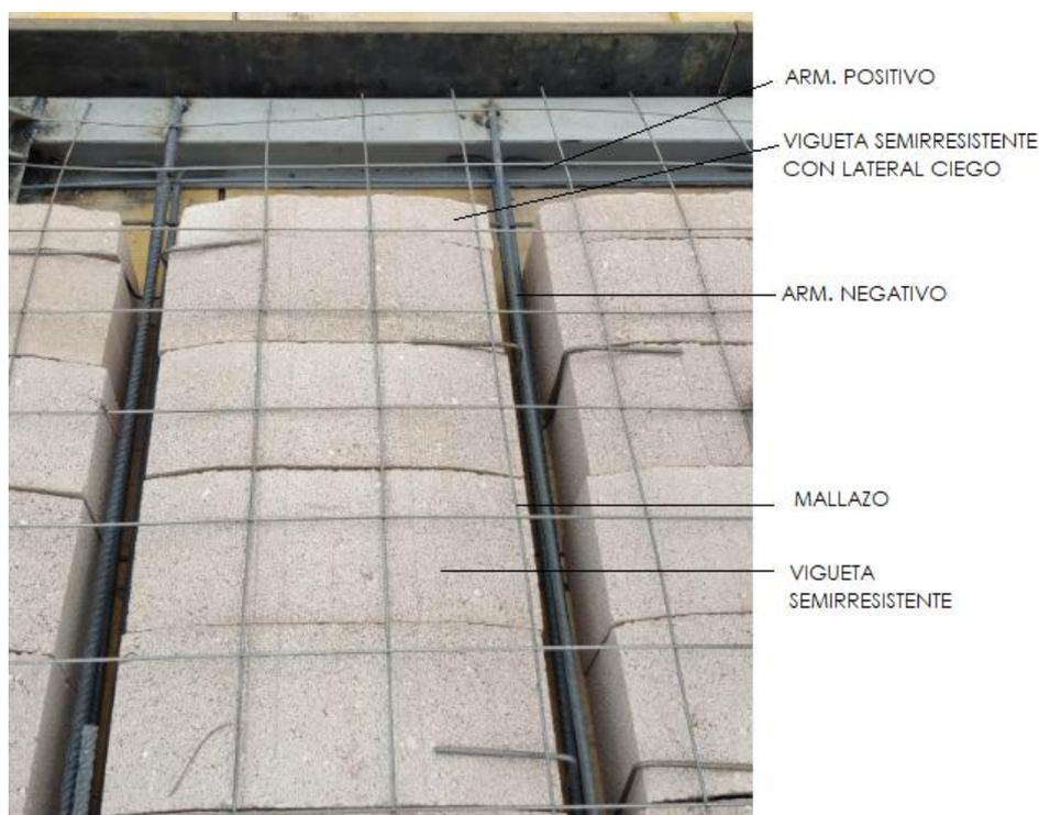
Imagen 5.33-Partes armado forjado unidireccional. Fuente propia.
