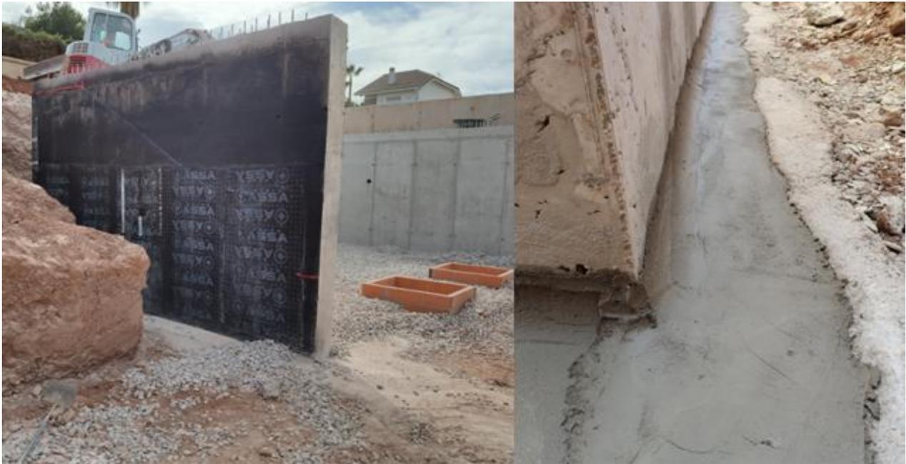
Imagen 5.14-Muros de sótano, medias cañas y arquetas 31/05/2019.IB10
