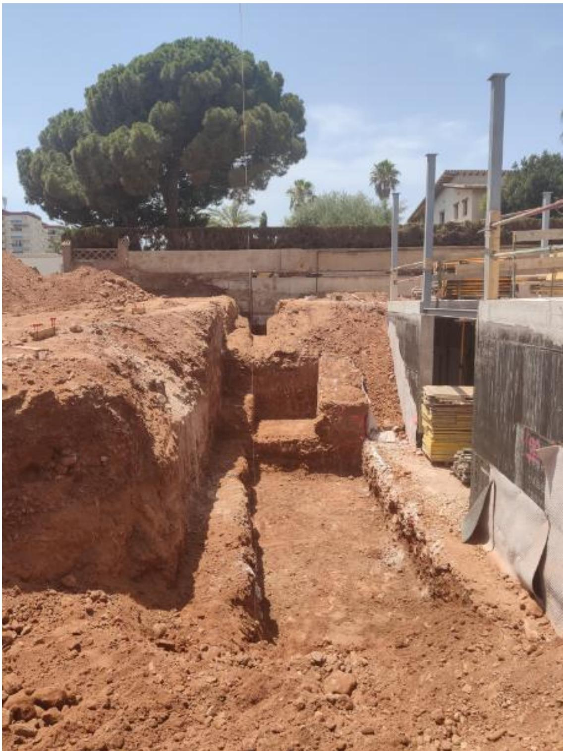
Imagen 5.17-Excavación zanja muro medianero y zapatas..28/06/2019.IB10.
