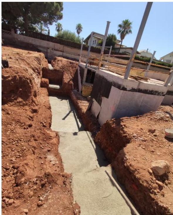
Imagen 5.18-Hormigón de limpieza.28/06/2019.IB10.
