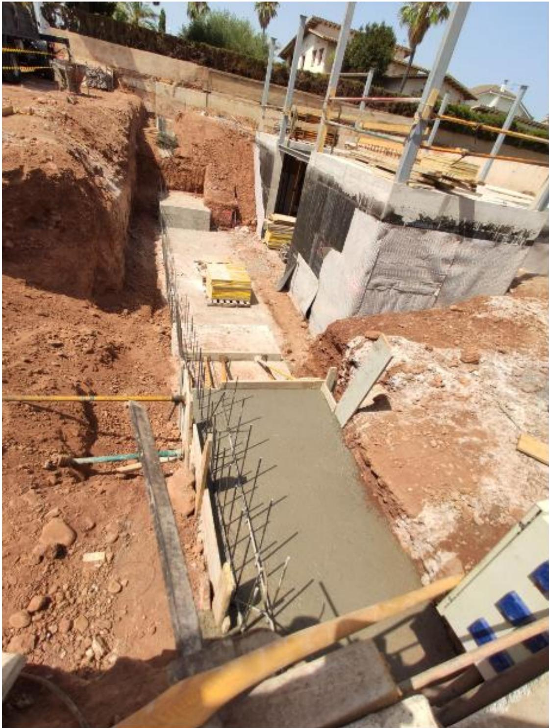
Imagen 5.24-Zapatas y saltos de zapatas.04/07/2019.Fuente propia.
