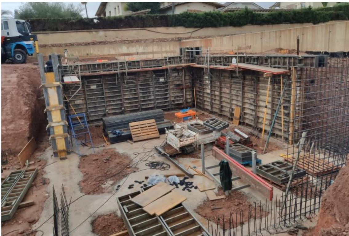
Imagen 5.13-Muros de sótano 24/05/2019.IB10.
