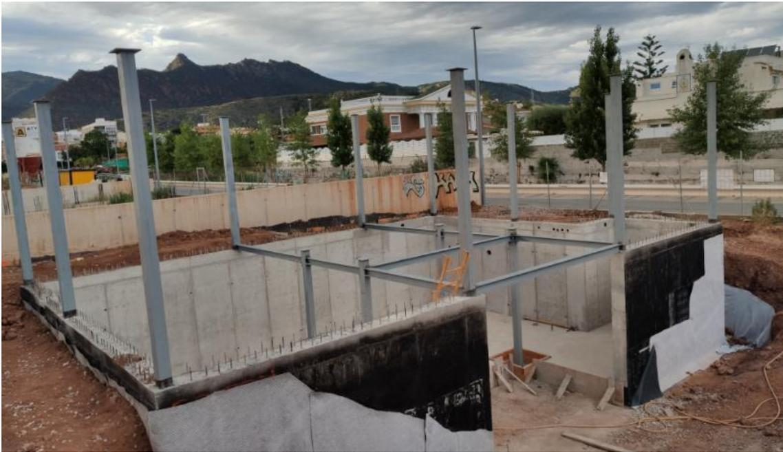
Imagen 5.16-Estructura metálica planta sótano y planta baja. 12/06/2019.IB10.
