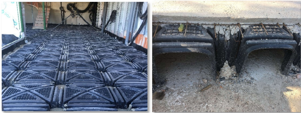
Figura 42 y 43 Forjado cáviti. (Foto tomada a pie de obra)
