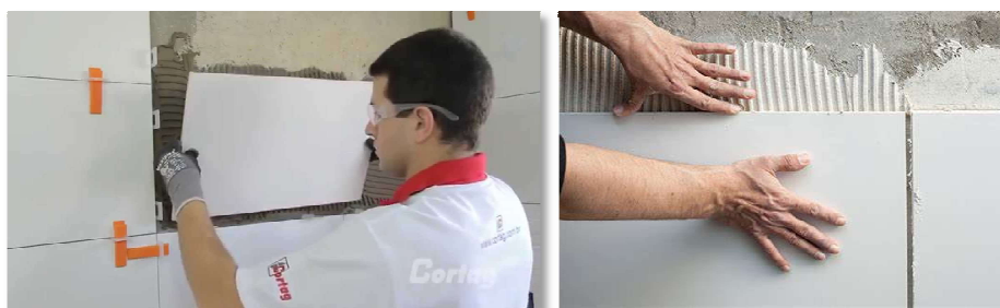
Figura 58 y 59 Colocación de azulejos. (Fuente internet)
