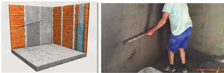
Figura 56 y 57 Maestreado de mortero en tabiquería. (Fuente internet)
