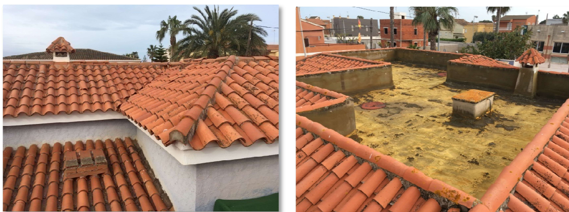
Figura 13 y 14 imágenes de la cubierta de la vivienda (Fuente autor).
