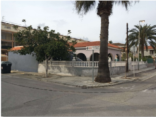
Figura 2 Calle Cerezo con calle nº11 (Fuente autor)
