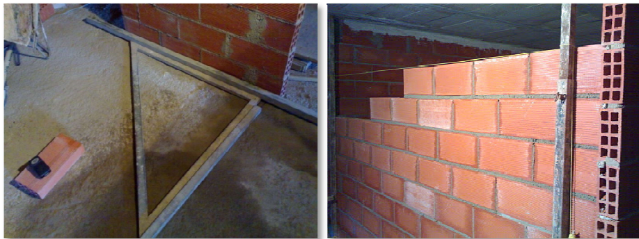
Figura 48 y 49 Construcción de la tabiquería. (Fuente internet)
