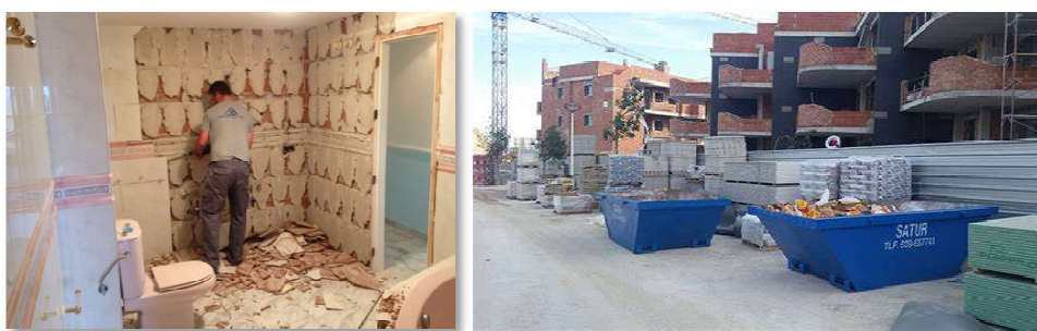
Figura 40 y 41 Derribos y escombros (fuente internet)
