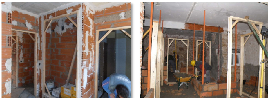
Figura 50 y 51 Construcción de la tabiquería. (fuente internet)
