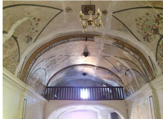
*Ilustración 66. Fisura en la bóveda de cañón de la Ermita de San Francisco Javier.*
