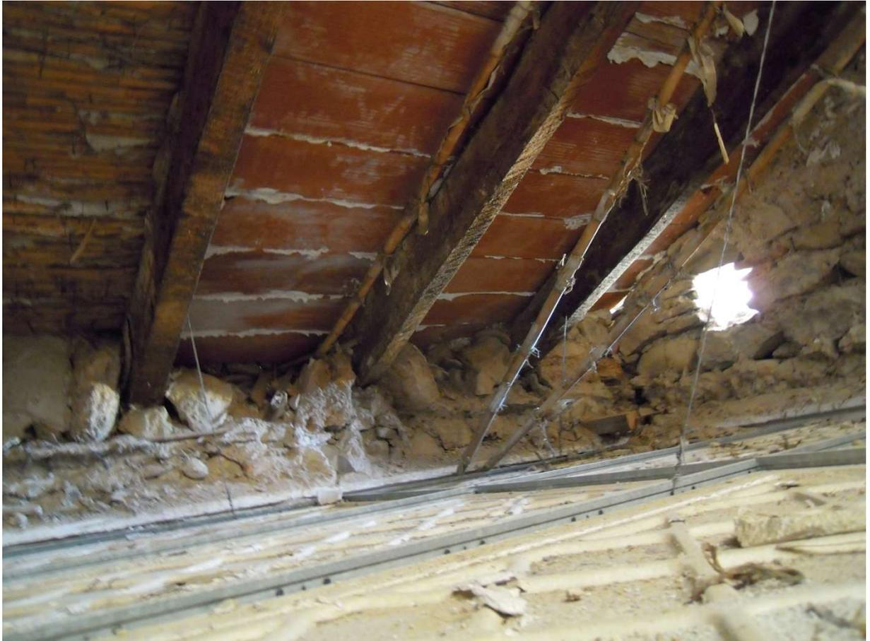
*Ilustración 70 Encuentro de viguetas de cubierta con el muro. Ermita de San Francisco Javier.*
