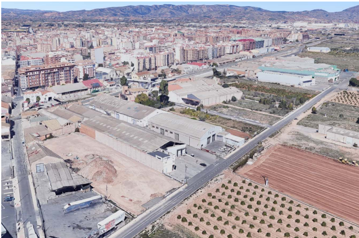
Figura 24. Vista de zona industrial colindante con zona de actuación (Fuente: Googlemaps)
