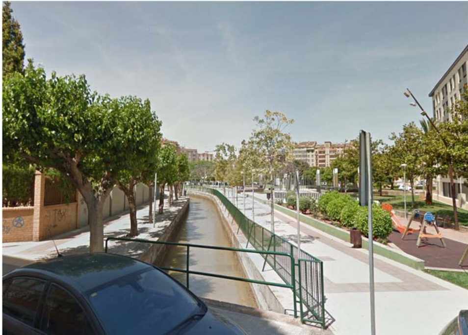
Figura 12. Vista de la Acequia Mayor en zona urbana (Fuente: Googlemaps)
