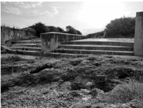
La Bota, pas soterrat de la séquia Sobirana pel riu Sec.
