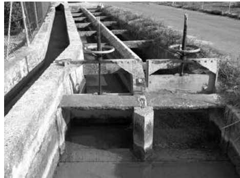
Partidor Major de les séquies Jussana i Sobirana, i comportes de la séquia Sobirana i la séquia de Nules.
