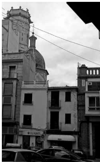
Ubicació aproximada del «castell de just». (Foto: P. Piqueras).
