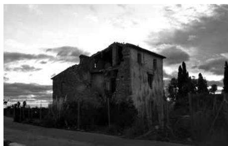
Casa del Batle. (Foto: P. Piqueras).
