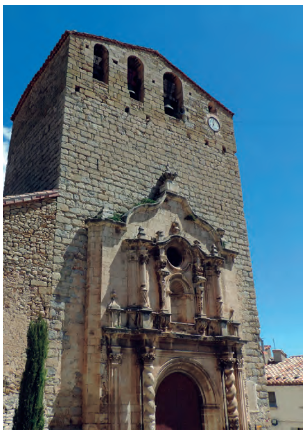
Figura 4. Torre de l'homenatge, actual campanar.
