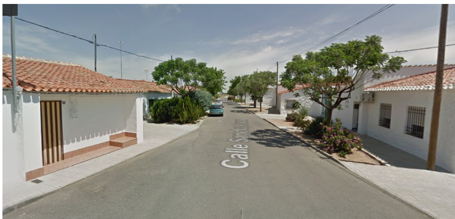
Imagen 9. Construcciones cercanas. (Fuente: Google Maps)
