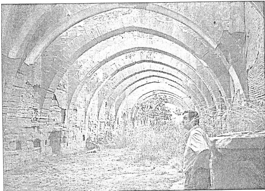
Claustro. Este recinto sufrió los destrozos del fuego en la Guerra Civil.
