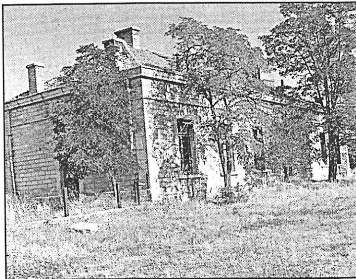
La estación más antigua de Caminreal es un edificio con gruesas paredes de piedra
