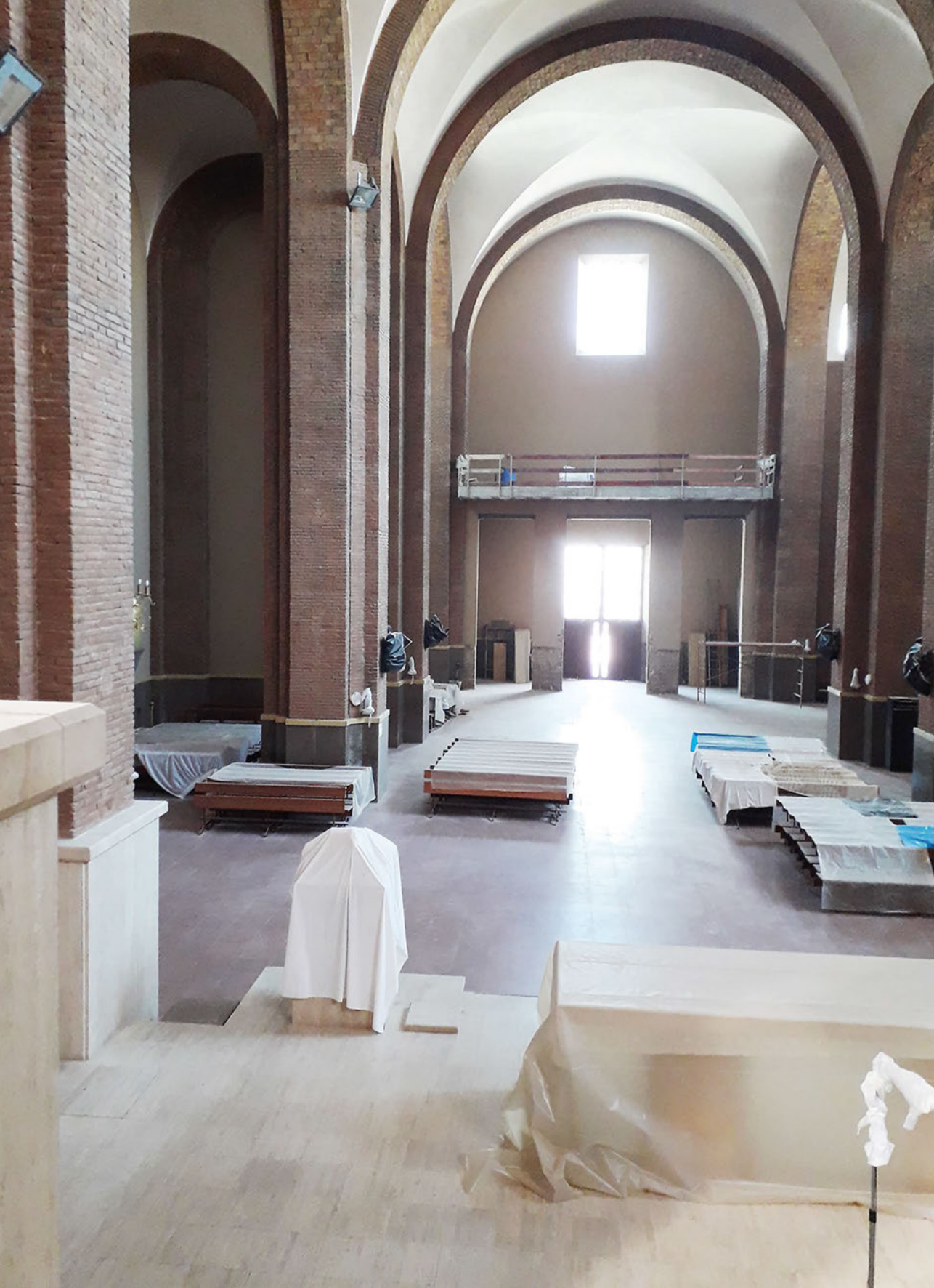
Aspecto de la Basílica en las obras de la cancela y coro de la puerta noroeste.
