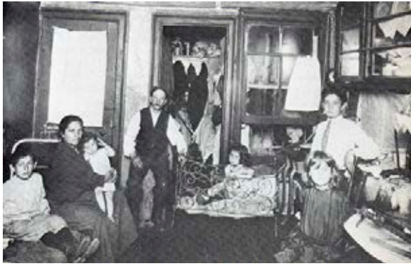
Interior de apartamento. Procedencia de la Fotografía: Tenement Museum
