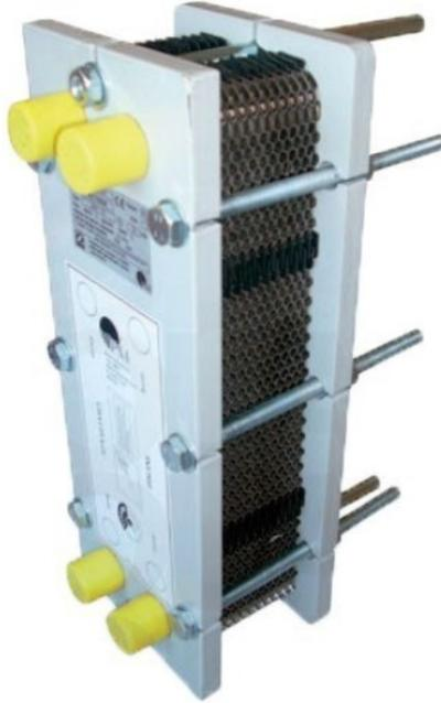
**Figura M7.13.** Intercambiador de calor de placas Hrale.
