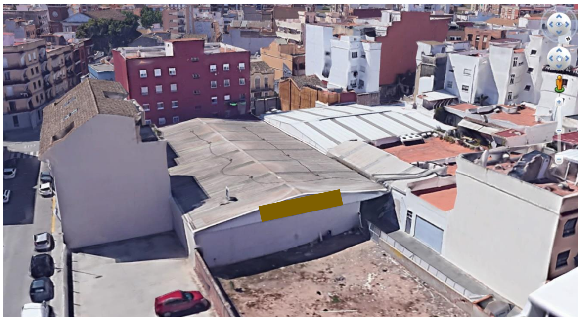
Figura 41: Vista a Sur de la cubierta de la nave. Fuente: Google Earth Pro.
