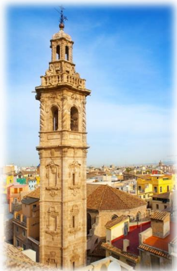
Figura 4. Torre-campanario. Iglesia de Santa Catalina
