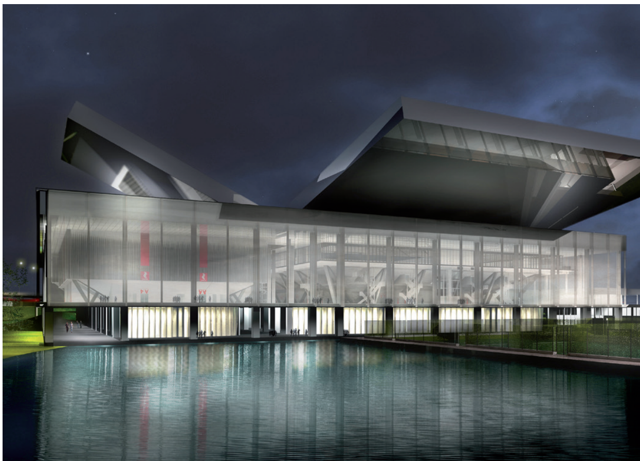
Instalación compensada por CYDESA. Caja Mágica (Madrid)
