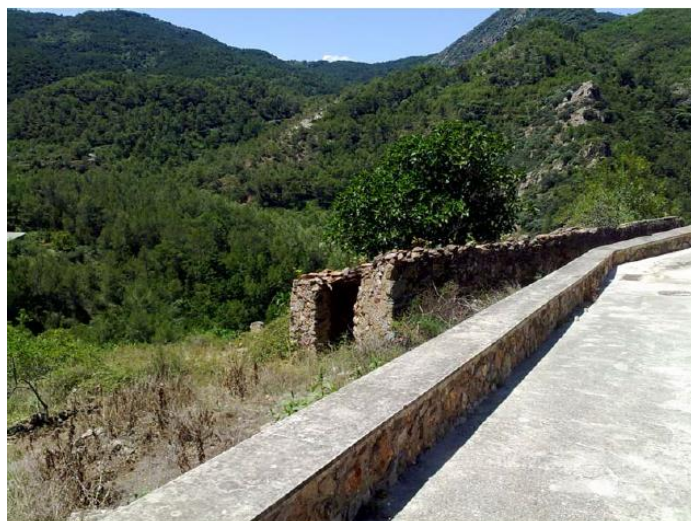
Figura. M. 3. Acceso a la parcela para el emplazamiento de la EDAR.
