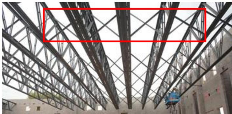
**Figura 40.-** Arriostramiento del cordón inferior de la celosía. Fuente: Weldersuniverse.com
