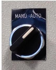
*Figura 44. Selector Manual/Automático (SS1) (Parte delantera)*
