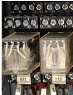
**Figura 37. "KA1 y KA2" Contactores sistema seguridad**
