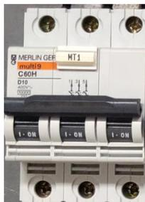
Figura 28. "MT1" Disyuntor magnetotérmico
