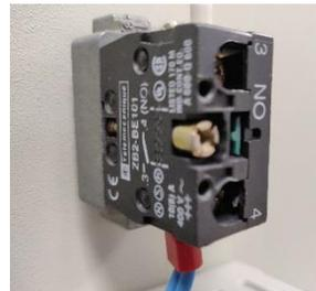
*Figura 43. Selector Manual/automático (SS1) (parte trasera)*
