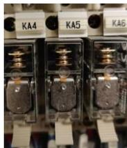
Figura 40. "KA4, KA5 y KA6" Relés referenciado ejes
