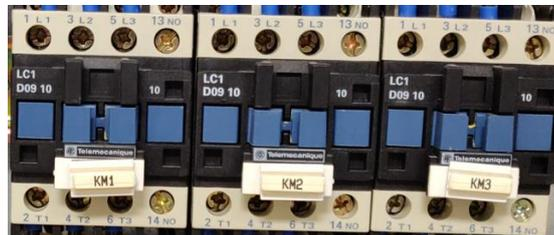
Figura 29. "KM1, KM2 y KM3" Contactores sistema seguridad
