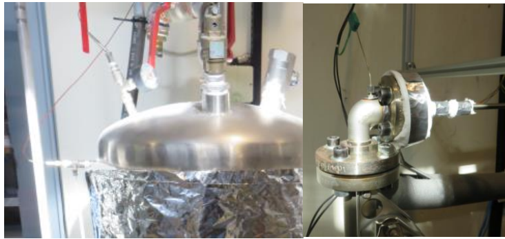
Figura 31. Imágenes de los termopares tipo K en la instalación.
