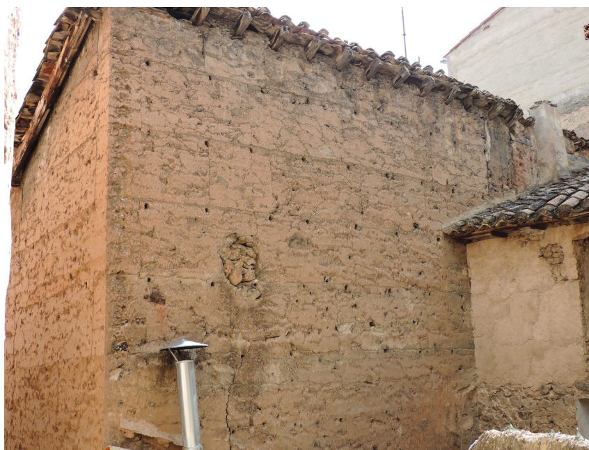
Figura 59. Fachada posterior. (Fuente: Propia)
