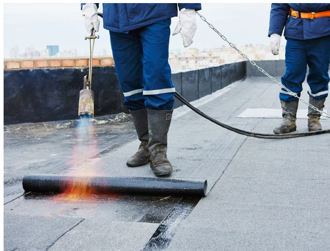
Figura 33. Instalación de impermeabilización en cubierta plana. (Fuente: CANTITEC)
