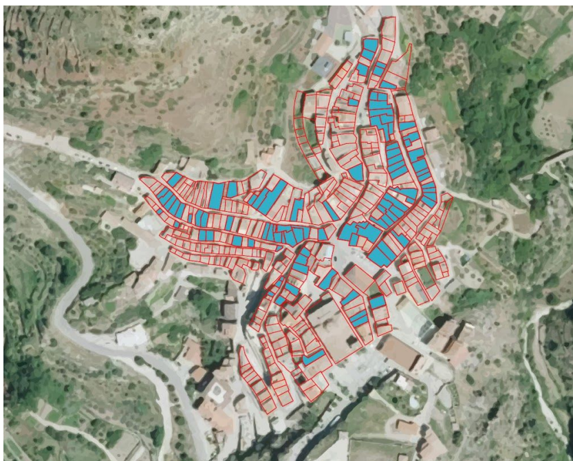
Figura 2. Viviendas con humedades detectadas en Villahermosa del Río. (Fuente: Propia)
