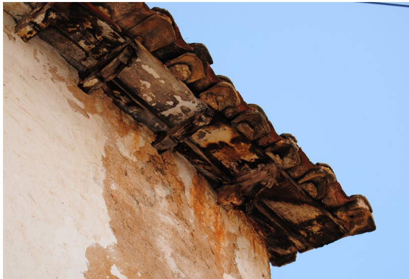
Figura 60. Alero de viguetas de madera continuas perpendiculares a la fachada. (Fuente: Propia)
