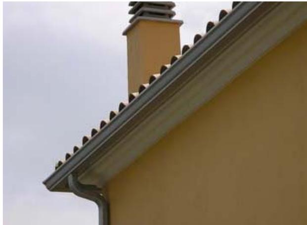
Figura 14. Canal3n de aluminio (Fuente: [www.canalumcatalunya.es](http://www.canalumcatalunya.es))
