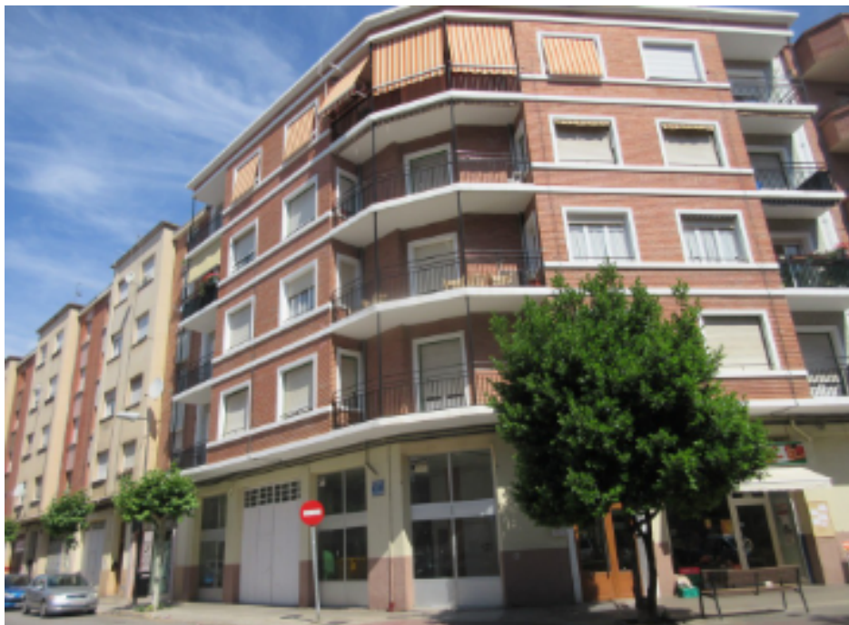
Fotografía de la fachada principal
