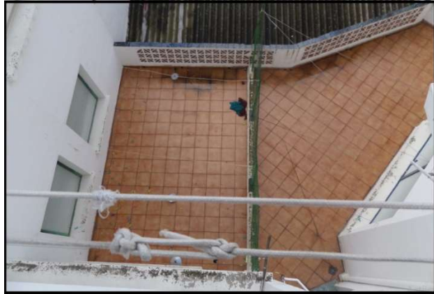
(Figura 5: Patio de luces)
