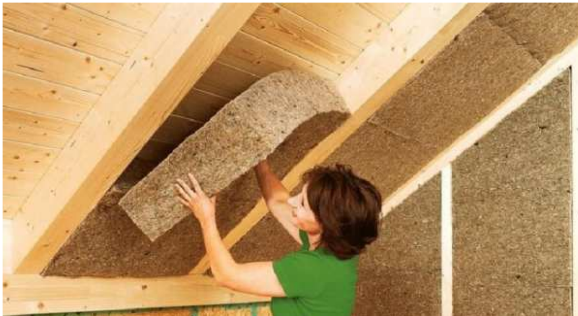
Figura 75: Aislamiento térmico en Casas Pasivas. Fuente: https://www.google.es/search
