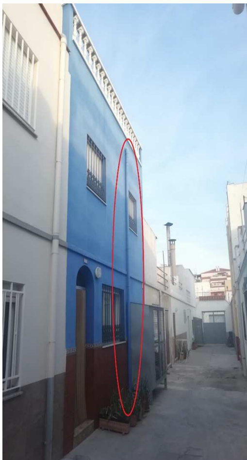
Figura 24: Vista de la bajante pluvial en la fachada trasera. Fuente propia
