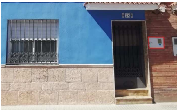
Figura 26: Zona suministro de energía Fuente propia
