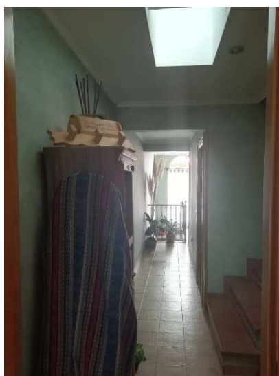
Figura 47: Lucernario. Fuente propia
