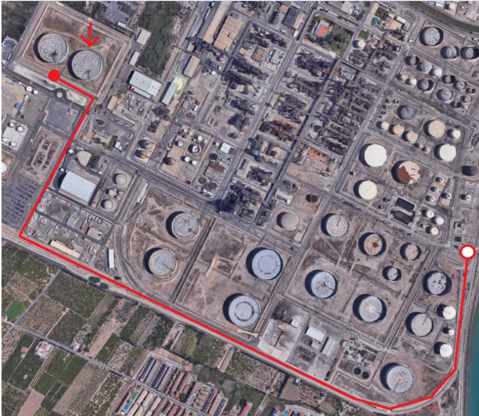
Ilustración 65: Trazado largo del incendio del tanque 3703.
