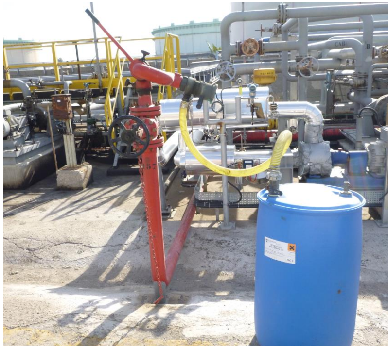
Ilustración 10: Ejemplo de hidrante con monitor de espuma aspirando de bidón de espumógeno.
