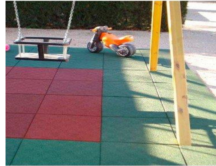
Figura 3.3. Pavimento de caucho.
