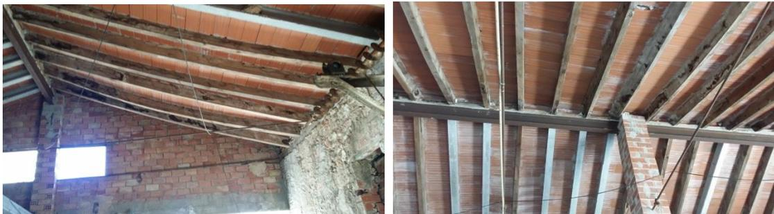
**CAUSAS:** La principal causa es la sobrecarga de la cubierta y la reducida sección de las vigas, también le afecta en menor medida los constantes cambios de humedad que generen dilataciones y contracciones. La actuación debería ser inmediata. Si no se actúa sobre esta lesión y los factores que originan éstas irán aumentando hasta la rotura.
