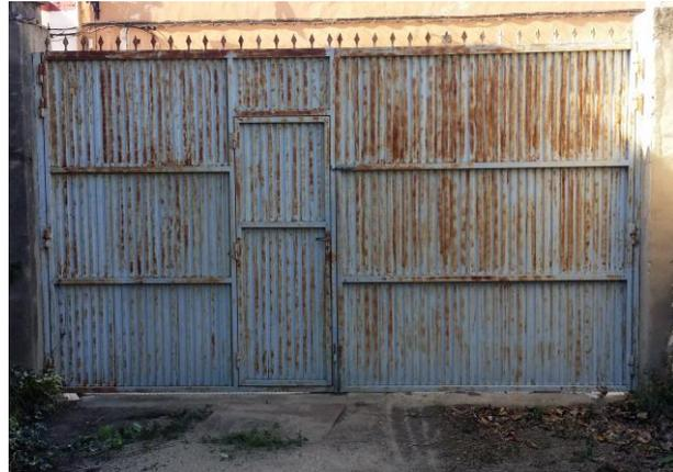
**CAUSAS:** La principal causa es la presencia de oxígeno del ambiente y del agua de lluvia. La transformación de los metales en óxido, se produce al entrar en contacto con el oxígeno, ya que la superficie del metal tiende a transformarse en óxido que es químicamente más estable.
