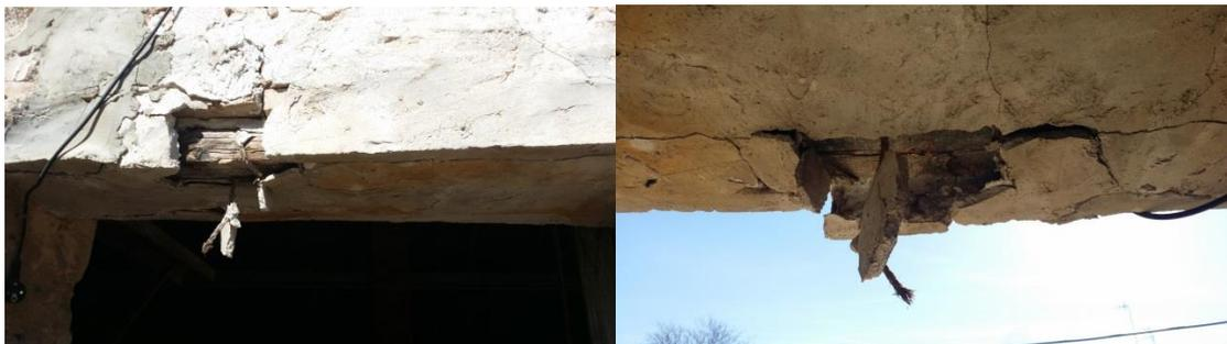
**CAUSAS:** Las causas son los agentes atmosféricos como el agua de lluvia, el viento, el asolamiento. Generalmente estas erosiones atmosféricas generan la meteorización de los materiales provocada por la succión del agua de lluvia, que si va acompañada de posibles heladas y de la dilatación correspondiente, rompe las láminas superficiales del material constructivo.
