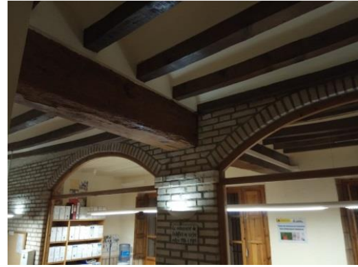
Fig. 137 Partición zona de trabajo planta baja. Fuente: Fotografía propia realizada, en el lugar de consulta 28/02/2019
