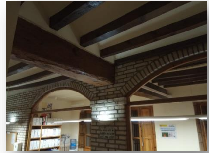
Fig. 180 Viga. Fuente: Fotografía propia realizada, en el lugar de consulta 28/02/2019
