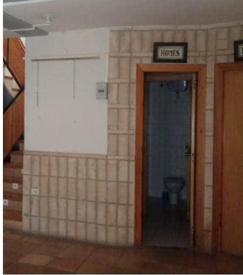
Fig. 139 Tabique aseos. Fuente: Fotografía propia realizada, en el lugar de consulta 10/04/2019
