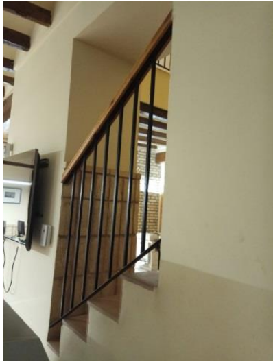
Fig. 119 Muro de carga escalera. Fuente: Fotografía propia realizada, en el lugar de consulta 24/01/2019
