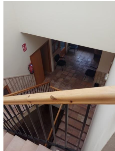
Fig. 153 Vista último tramo. Fuente: Fotografía propia realizada, en el lugar de consulta 06/03/2019
