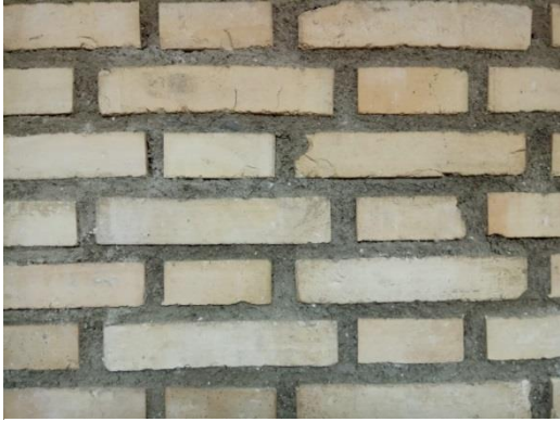
Fig. 136 Aparejo inglés. Fuente: Fotografía propia realizada, en el lugar de consulta 28/02/2019
