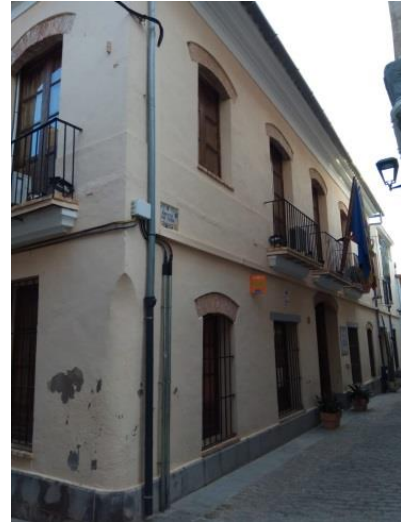
Fig. 120 Muro de carga fachada. Fuente: Fotografía propia realizada, en el lugar de consulta 24/01/2019
