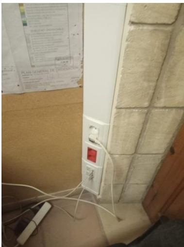
Fig. 225 Canaleta vertical. Fuente: Fotografía propia realizada, en el lugar de consulta 27/06/2019
