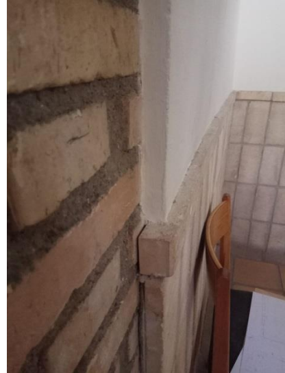
Fig. 165 Espesores revestimientos. Salón de actos. Fuente: Fotografía propia realizada, en el lugar de consulta 10/04/2019
