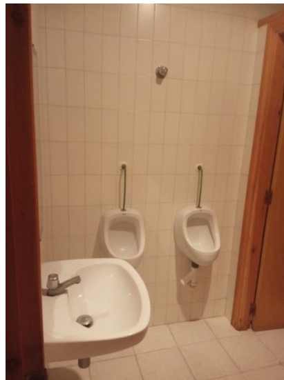
Fig. 166 Alicatado. Aseos salón de actos. Fuente: Fotografía propia realizada, en el lugar de consulta 10/04/2019
