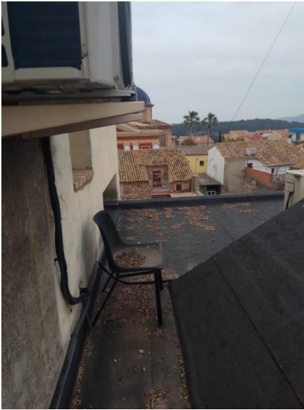
Fig. 62 Acceso a cubierta, vista exterior. Fuente: Fotografía propia realizada, en el lugar de consulta 06/03/2019
