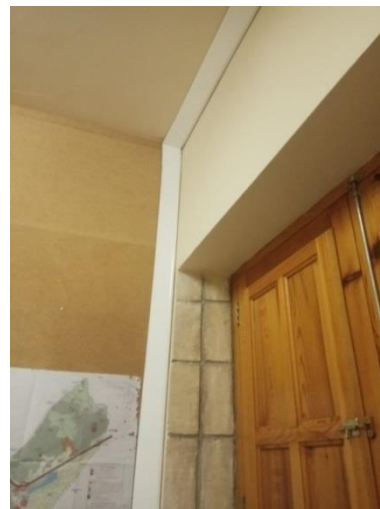
Fig. 226 Canaleta horizontal. Fuente: Fotografía propia realizada, en el lugar de consulta 27/06/2019
