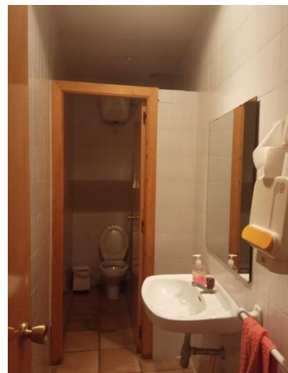
Fig. 158 Alicatado aseo mujeres. Fuente: Fotografía propia realizada, en el lugar de consulta 27/06/2019
