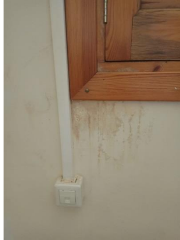
Fig. 199 Deterioro 5 carpintería salón de actos. Fuente: Fotografía propia realizada, en el lugar de consulta 10/04/2019
