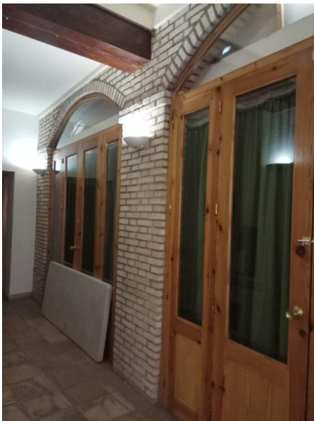
Fig. 30 Medianera, vista 1. Fuente: Fotografía propia realizada, en el lugar de consulta 25/04/2019
