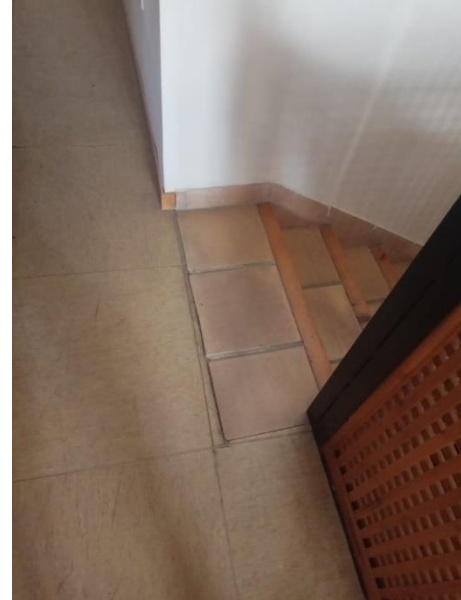
Fig. 171 Encuentro pavimento PVC y cerámico. Fuente: Fotografía propia realizada, en el lugar de consulta
