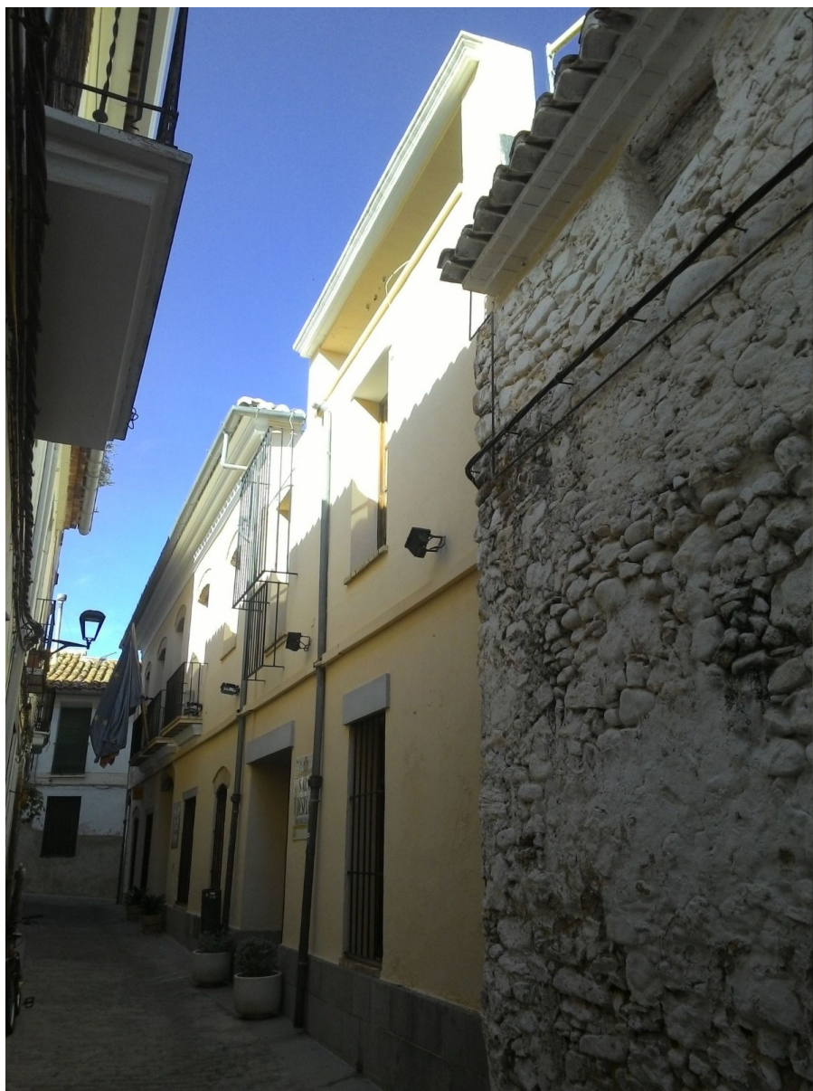
Fotografía de la fachada principal
