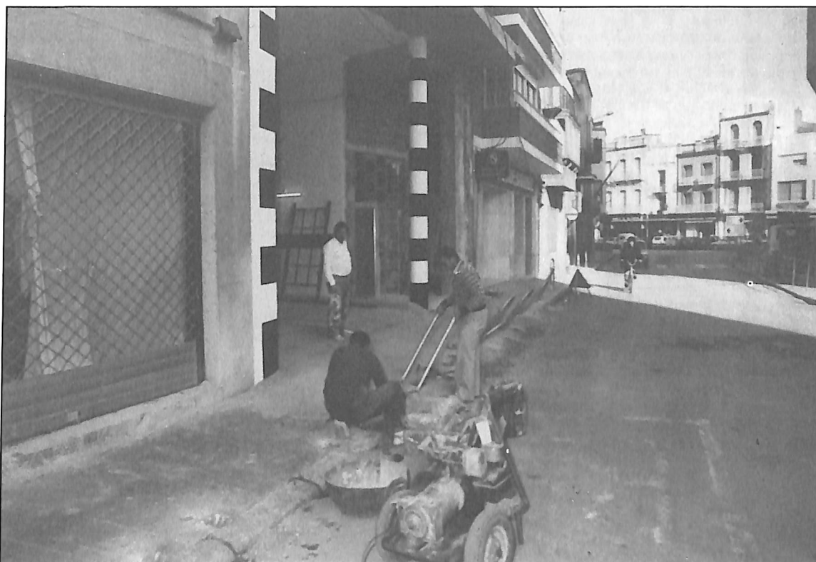
La orden de Bofill de cerrar el paso pretende disimularla diciendo que la instalación de talanqueras es rutinaria.
