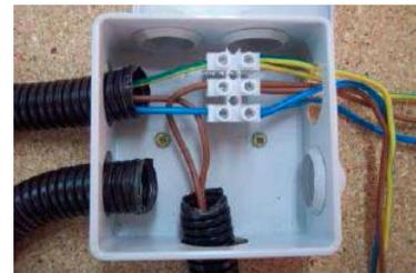
La sección (grosor) de los cables conductores depende de cada circuito. Como se ve en la imagen, el circuito independiente C1 destinado a iluminación requiere de cables de sección 1,5 mm<sup>2</sup>, mientras que el circuito independiente C3 que alimenta las tomas de cocina y horno requiere de conductores de sección 6 mm<sup>2</sup>. La sección de los conductores se elige en función de la intensidad de corriente a transportar: a más intensidad, mayor es la sección del cable.
