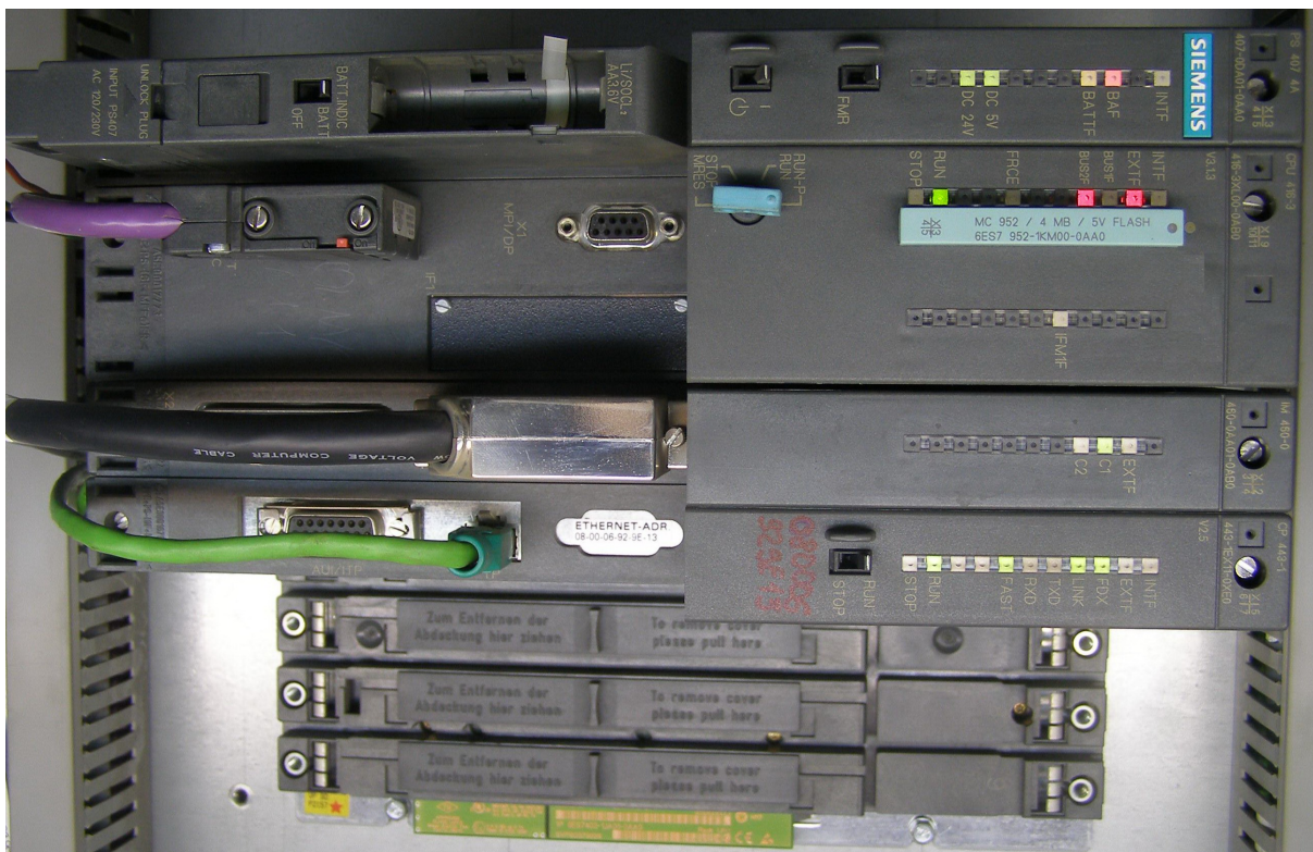
Figura 2.2: PLC Siemens Simatic S7-400, de arriba a abajo: fuente de alimentación, CPU, módulo de interfaz y el procesador de comunicaciones [1].
