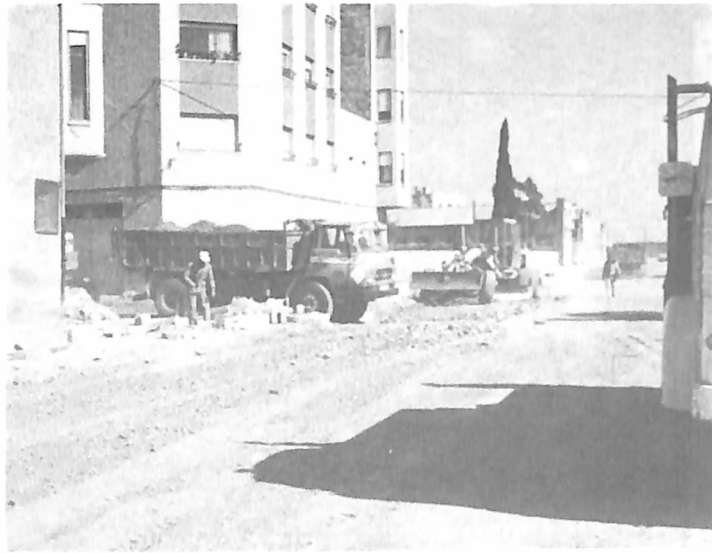
Obras Avenida Cataluña
