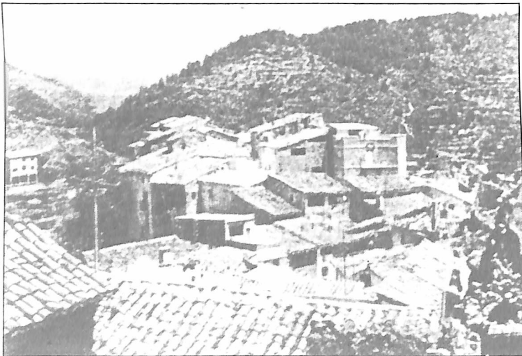
CASTELLMONTÁN. Conjunto urbano que responde al emplazamiento del castillo árabe.
