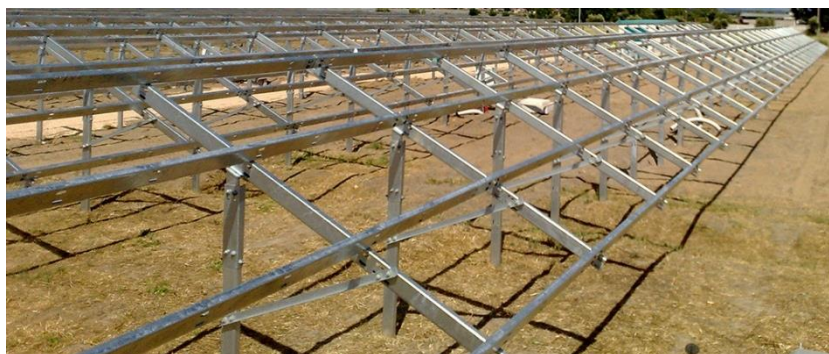
Figura 23. Estructuras soporte in situ
